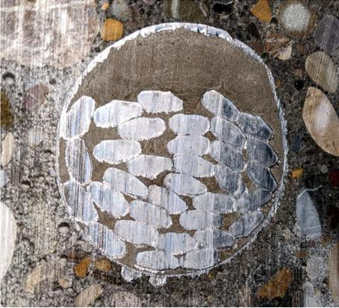
**Bild 7:** Schnittfläche eines mittels Kernbohrung durchtrennten Spannglieds mit minimalen Einzügen der Spanndrähte (< 1 mm)
