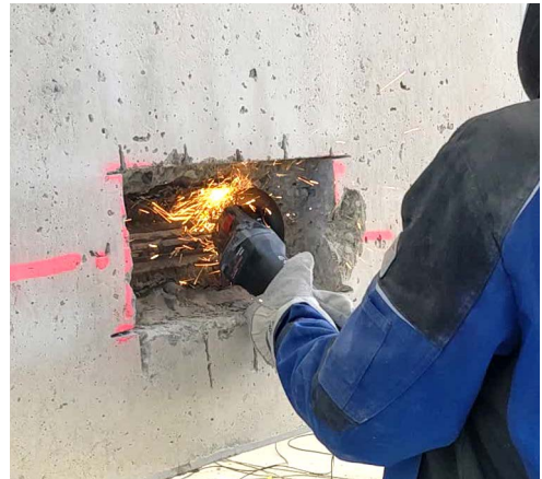
Bild 6: Durchtrennung der Spannglieder mittels Trennschleifer an Sägeschnitten
