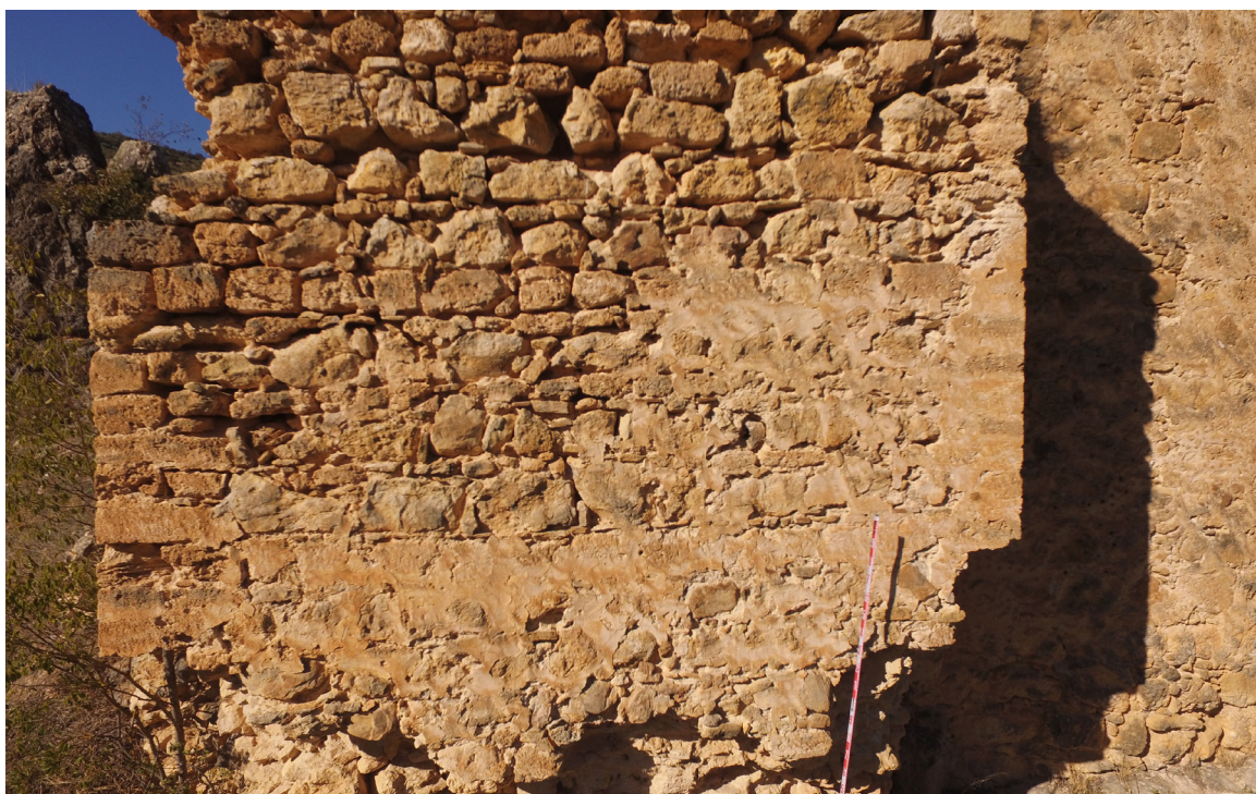
Fig. 14. Imagen de la mampostería enripiada con las esquinas reforzadas con sillares de calcarenita.
