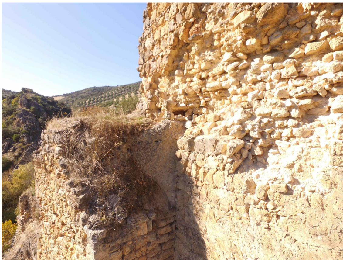
Fig. 5. Imagen de la tapia hormigonada detectada entre el machón sur y la torre ultrasemicircular.
