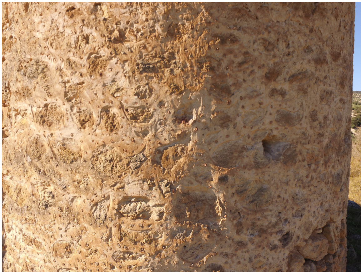
Fig. 15. Imagen de mampostería envitolada con forma de lágrima y decoración con inserción de escorias de metal.
