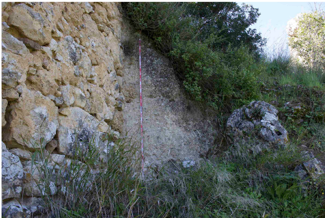
Fig. 6. Imagen de la tapia hormigonada entre torre ultrasemicircular y macizo rocoso.
