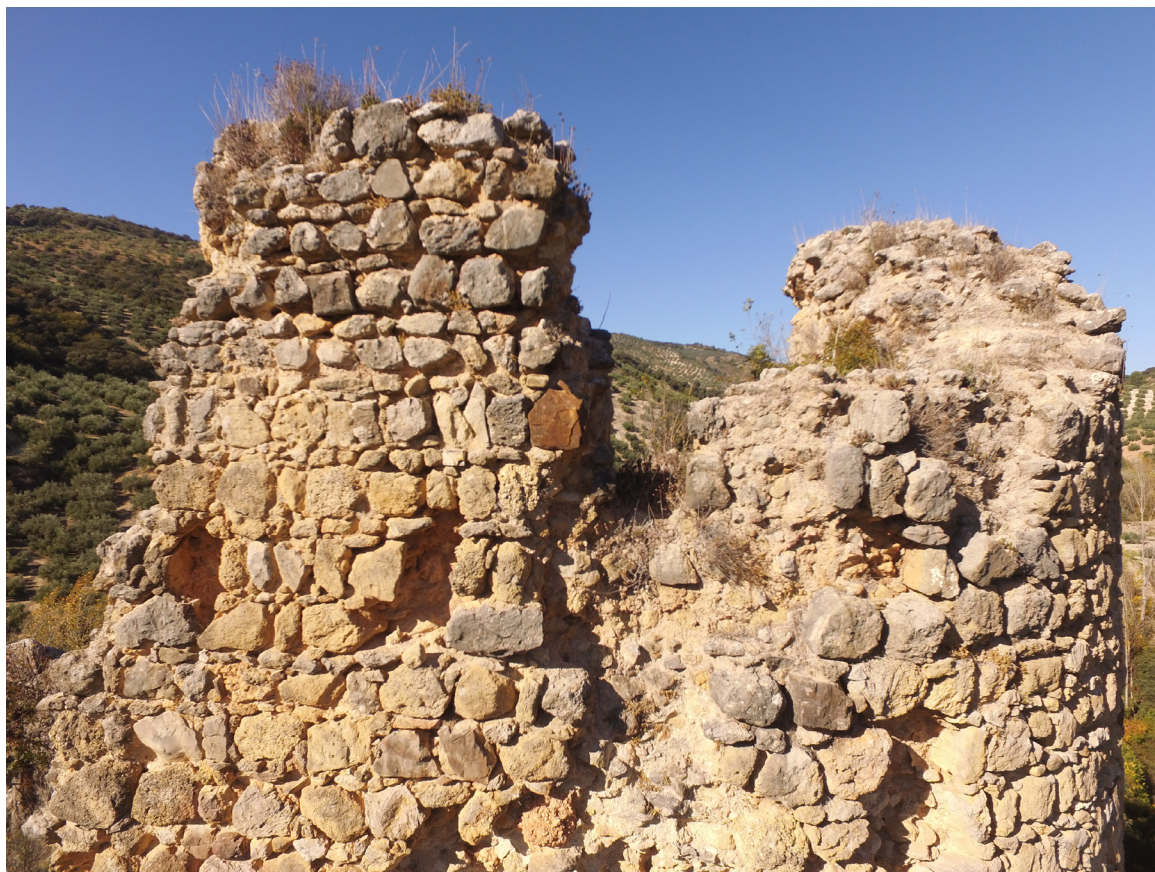
Fig. 17. Imagen de dron donde se aprecia una posible ventana de la torre.
