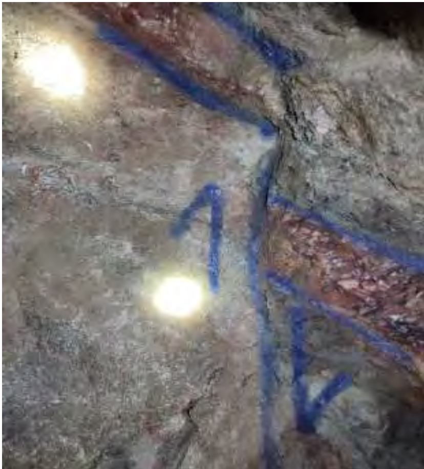
Falla norma que desplaza a la veta filomena.
