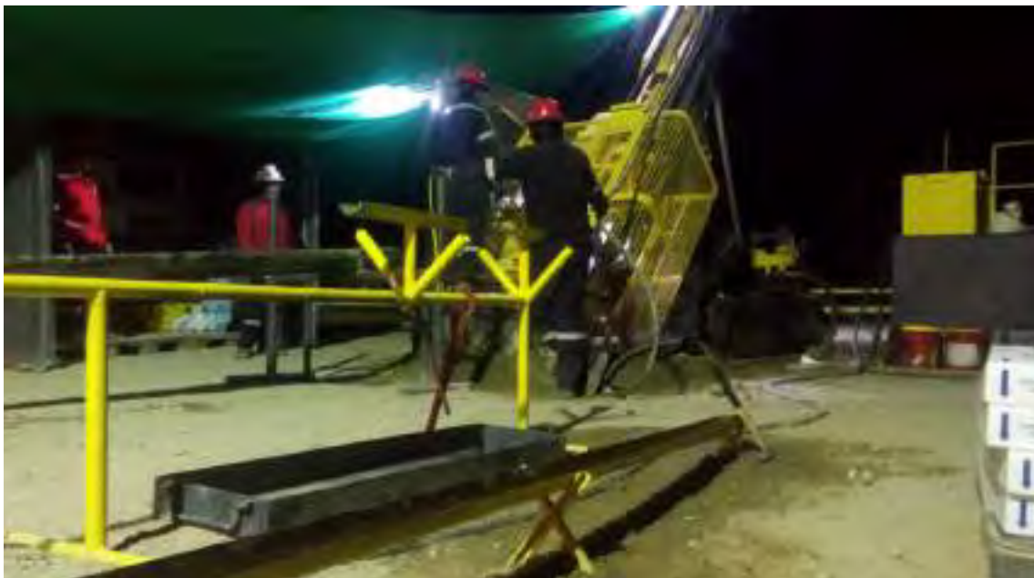
Trabajos de perforación diamantina en el turno noche.
