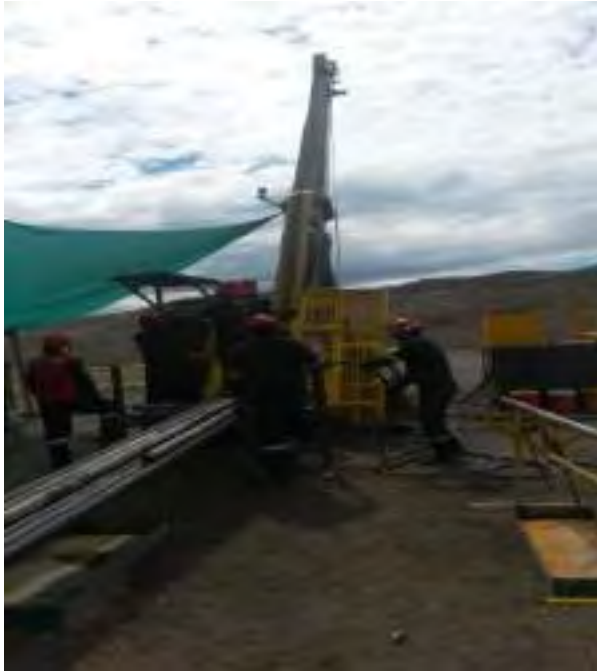
Trabajos de perforación diamantina en el turno día.
