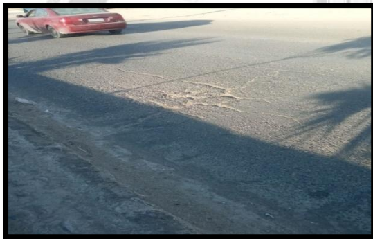
Longitudinal crack
