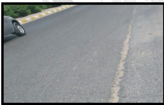
Edge crack
