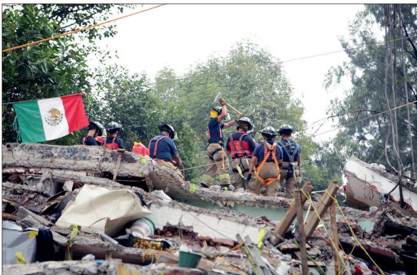
Figura 1. Consecuencias del sismo del 19 de septiembre de 2017, Ciudad de México (Foto de Eloy Valtierra, cortesía del autor).
