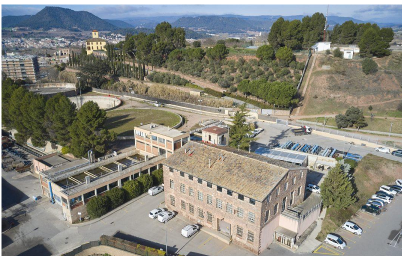
Figura 47. Planta Potabilitzadora de Manresa
