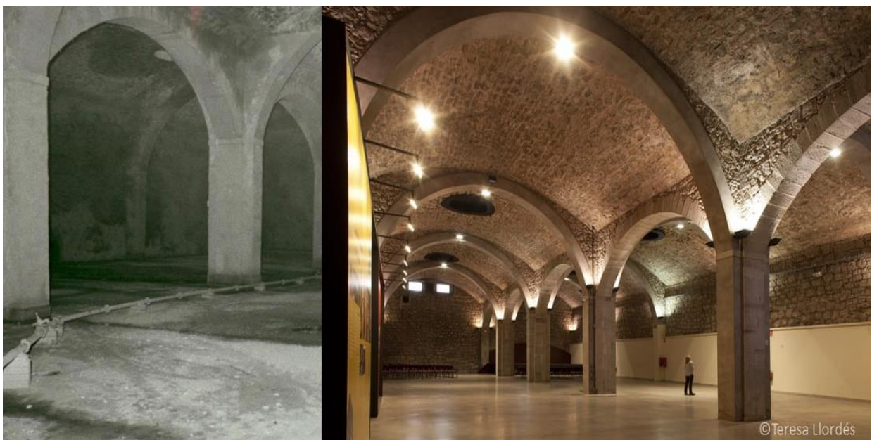
Figura 39. Esquerra dipòsits vells, dreta dipòsits Vells a l'actualitat com a Museu de la Tècnica de Manresa
