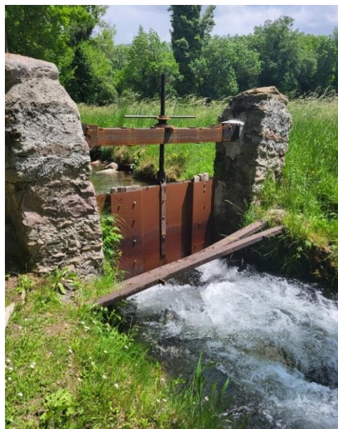
Il·lustració 12: Presa situada a un kilòmetre de la Mola
