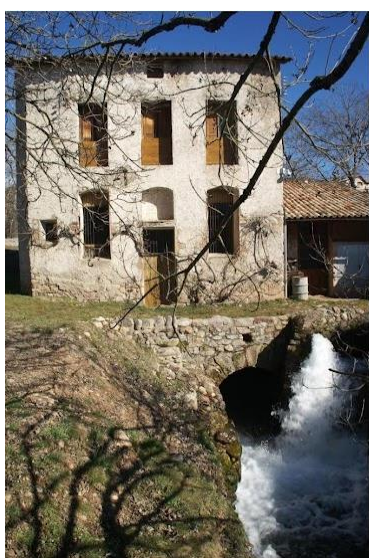
Il·lustració 15: Façana sud-oest i desaigüe de les turbines
