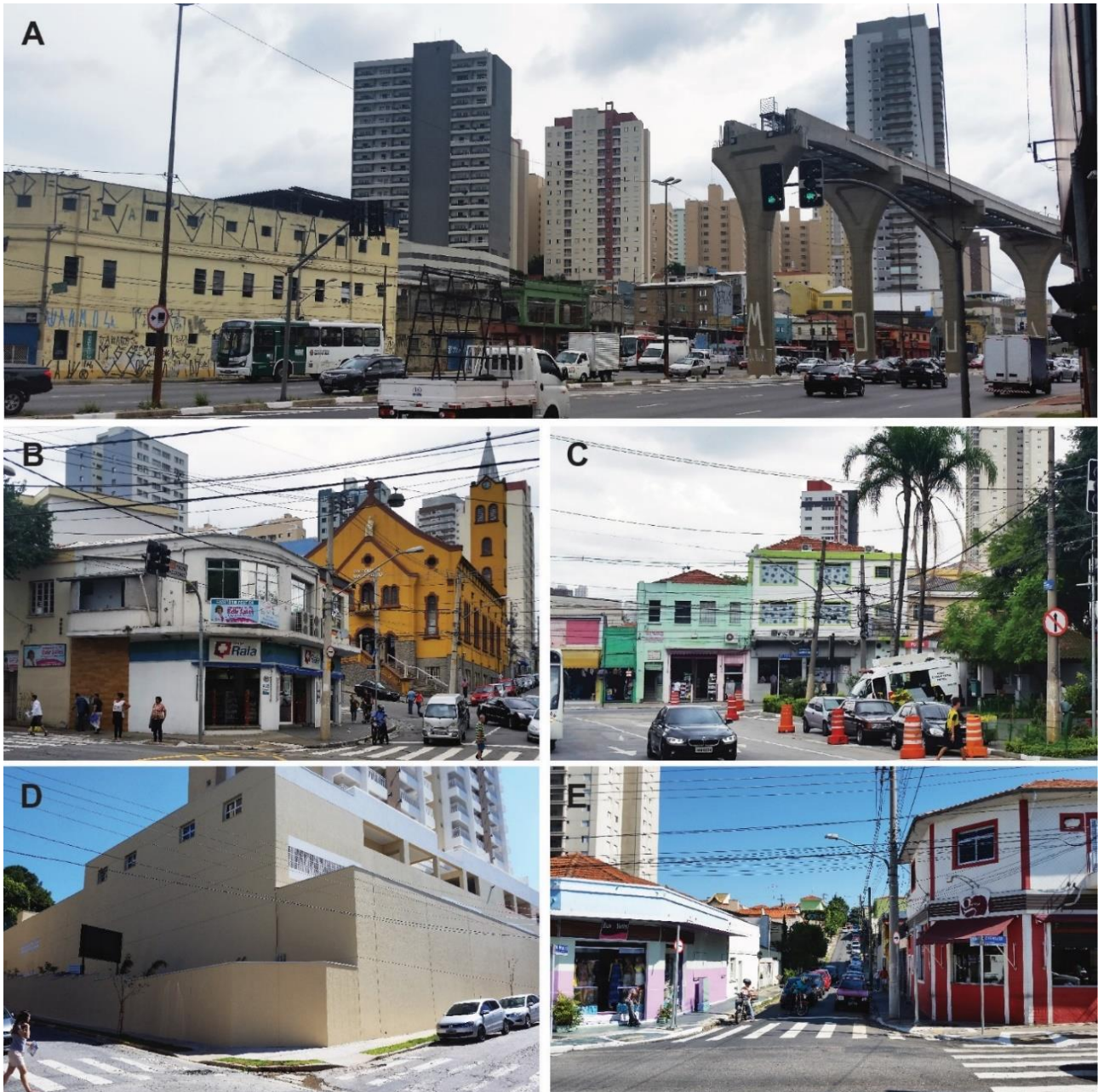
Fig. 6: Paisagens e tipos do PVP: (A) cuore do polo desde a Av. Anhaia Melo destacando o viaduto do monotrilho, a verticalização recente e o conjunto 'disforme'; (B) e (C) no Largo da Vila Prudente, observa-se a persistência de tipos singelos (D); 'antiurbanidade' a cerca de 50m do centro do polo; e (E) tipos edifícios remanescentes da ocupação original. Fonte: Acervo pessoal, 2016.
