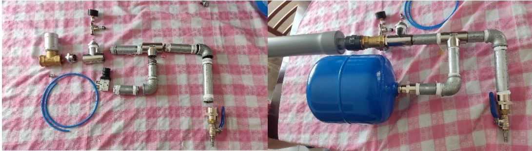
FIGURA 64 Muntatge canó final
