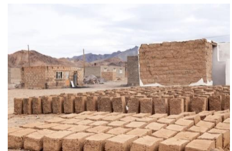
Fábrica de secado al sol de ladrillo de adobe
