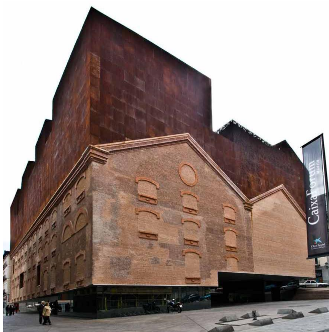
Figura 07. Caixa fórum Madrid, antigua Central Eléctrica del Mediodía (Factoría 5, 2021).
