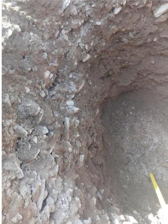
Foto N°2: Realización de la prueba de Percolación en Pozo.
