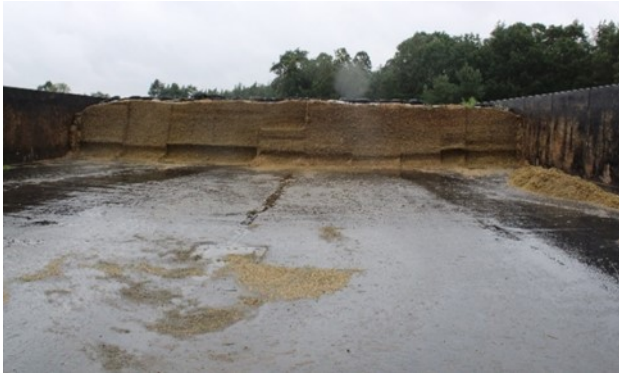
besenreiner Boden vor der Anschnittfläche
