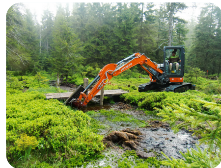
Mit einem Bagger werden Abflussbahnen verschlossen. Ein hoher Wasserstand im Moor soll nach vielen Jahren für neue Torfbildung sorgen.
