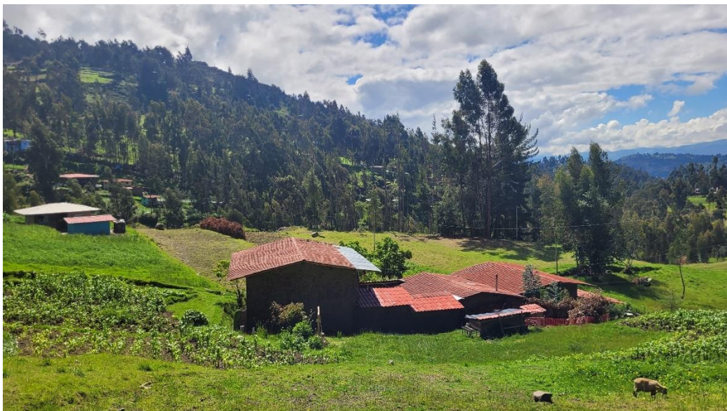
Fotografía 6. Viviendas en peligro ubicadas en la parte baja del deslizamiento. Ubicación: E: 767523; N: 9216773; Z: 3196.
