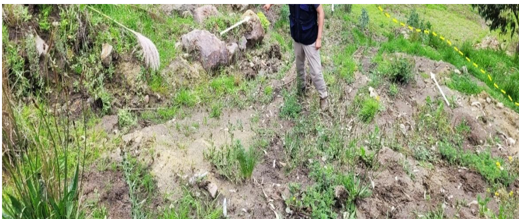
Figura 14. Parte central del deslizamiento, donde se aprecian bloques de hasta 1 m de longitud en peligro de desprenderse ladera abajo.
