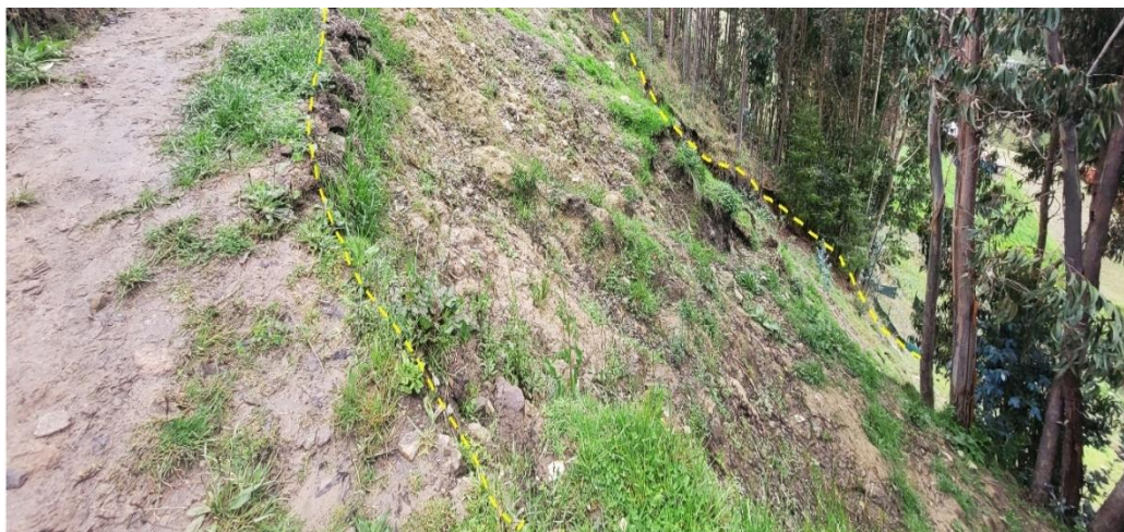
Figura 12. De la parte superior del deslizamiento Chaupimayo, donde se aprecia la corona del movimiento que está afectando a la trocha local.
