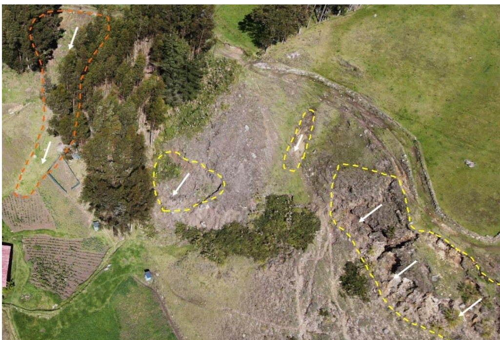
Figura 16. Vista de los derrumbes activos (en línea amarilla) ubicados al noreste del deslizamiento activo (en línea naranja).
