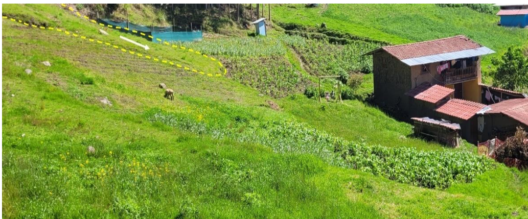
Figura 15. Vista de la punta del deslizamiento, donde se aprecian las viviendas que están en peligro ante una reactivación del movimiento.
