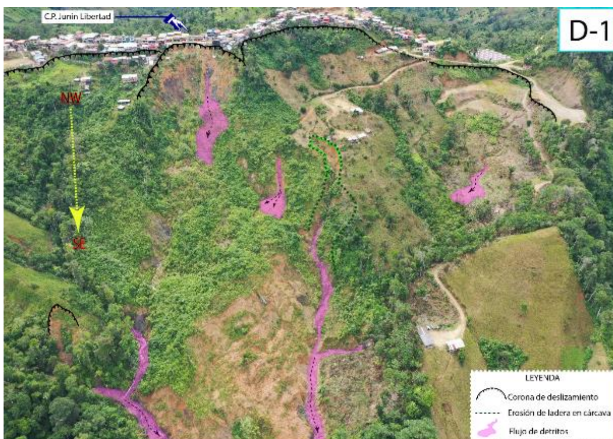
Figura 11. Vista del deslizamiento rotacional (D-1), con dirección de desplazamiento NW-SE. Fuente: Fotografía capturada por el dron el día de inspección en el C.P. Junín Libertad (26/03/2022).
