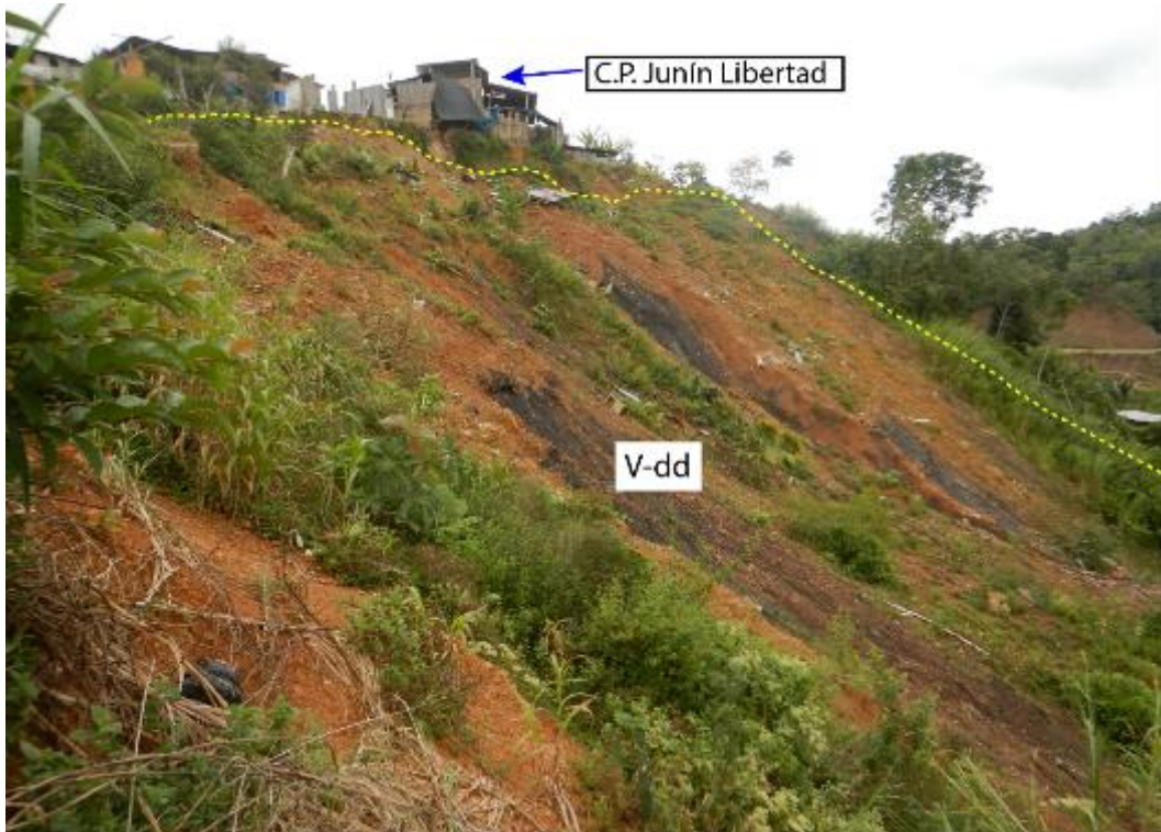
Figura 9. Vista de la subunidad geomorfológica, vertiente con depósito de deslizamiento (V-dd), corresponde al cuerpo del deslizamiento.
