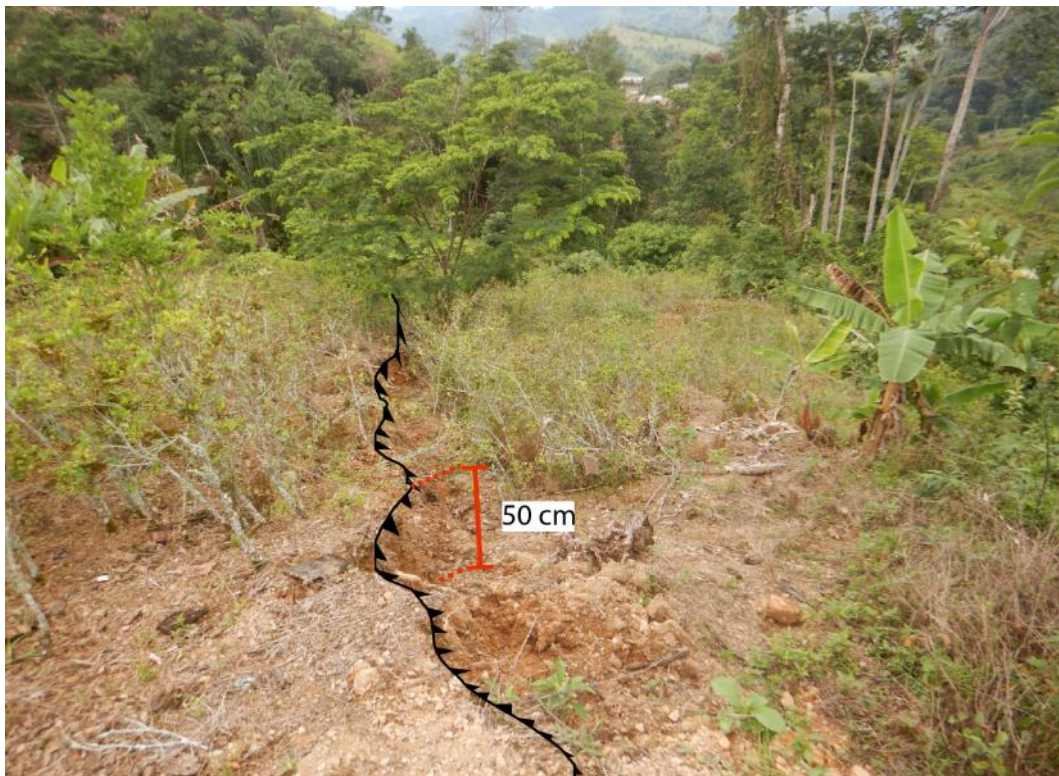
Figura 16. Vista de un escarpe con un salto de 50 cm, con dirección SE, ubicado con coordenadas UTM (WGS 84): 607476 E; 8630519 N.
