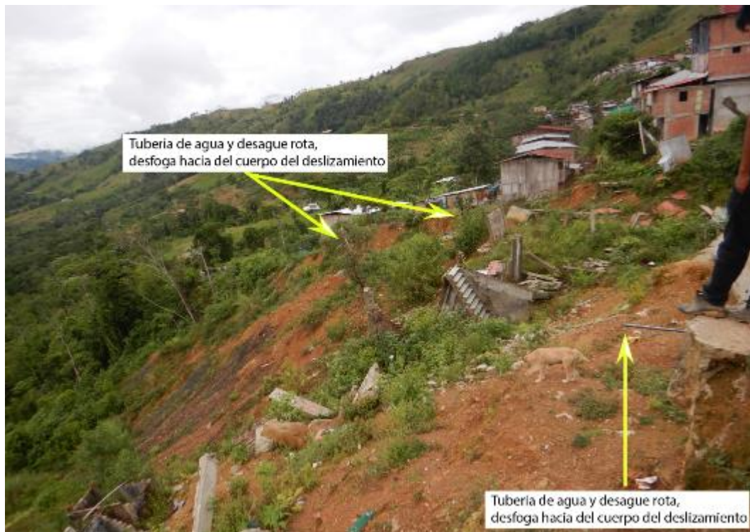
Figura 14. Vista de tuberías de agua y desagüe rota que desfoga directamente sobre el cuerpo del deslizamiento
