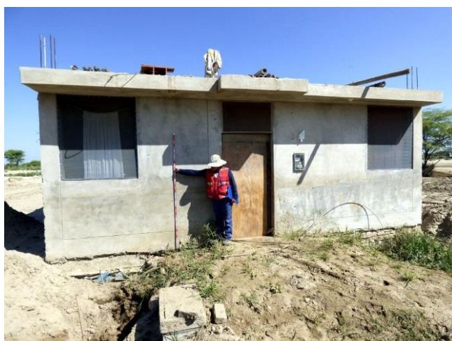
Foto 7: La altura del agua alcanzada por las inundaciones que afectaron el poblado Pedregal Chico fue de hasta un metro.
