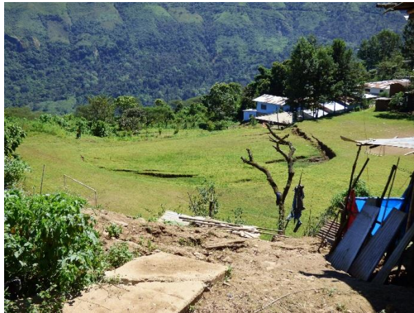
Foto 19: Deslizamiento activo que produjo el asentamiento de un campo deportivo; el deslizamiento se ha reactivado en el cuerpo de un evento antiguo. Sector Palambra.
