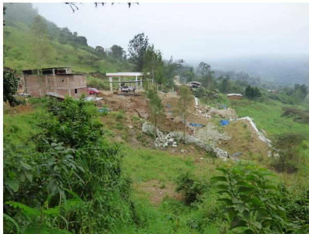
Foto 20: Deslizamiento activo en San Miguel del Faique, destruyó parte de las instalaciones de un grifo; este evento se produjo en una zona de la ladera afectada por flujos de tierra.
