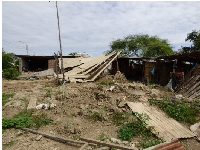
Foto 13: Vivienda destruida en el sector Chato Chico, también por las aguas desbordadas por rotura del muro de encauzamiento de la margen izquierda del río Piura.
