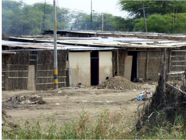
Foto 9: Inundación que afectó el sector Pedregal, el nivel del agua alcanzó poco más de un metro, lleno de lodo las viviendas.
