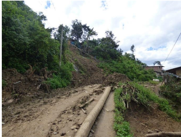
Foto 18: Trocha carrozable en el distrito Yamango, afectada por un derrumbe que obstruyo el tránsito hacia Huancabamba.
