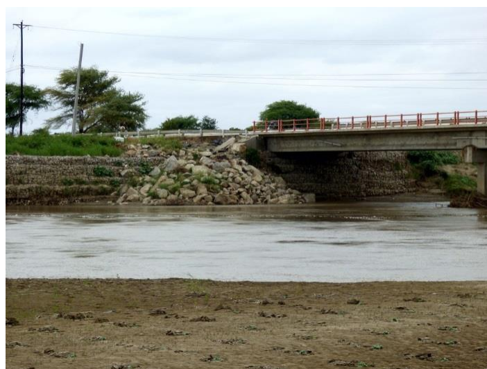
Foto 35: Erosión en el estribo de la margen izquierda del puente Independencia, se necesita realizar trabajos de reforzamiento de las defensas ribereñas.
