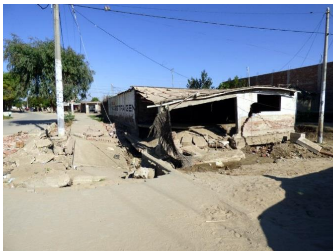
Foto 6: Vivienda destruida en Catacaos por el curso de agua formado en las calles como consecuencia de la rotura del muro de encauzamiento en el sector El Rancho.
