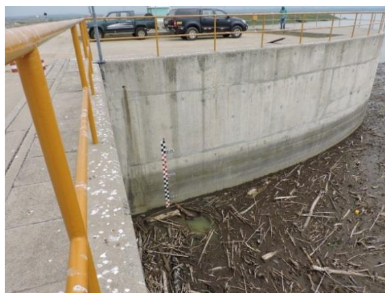
Foto 5: El reservorio Poechos cuya capacidad de almacenamiento al inicio de su construcción fue de 1000 millones de m^3 ; desde sus inicios hasta la actualidad, ha ido colmatándose de material detrítico reduciendo su capacidad de almacenamiento a menos del 50%. Actualmente la represa tiene una capacidad para almacenar agua en un volumen de 400 millones de m^3 ; en la imagen se observa el material que colmata el vaso de la presa.
