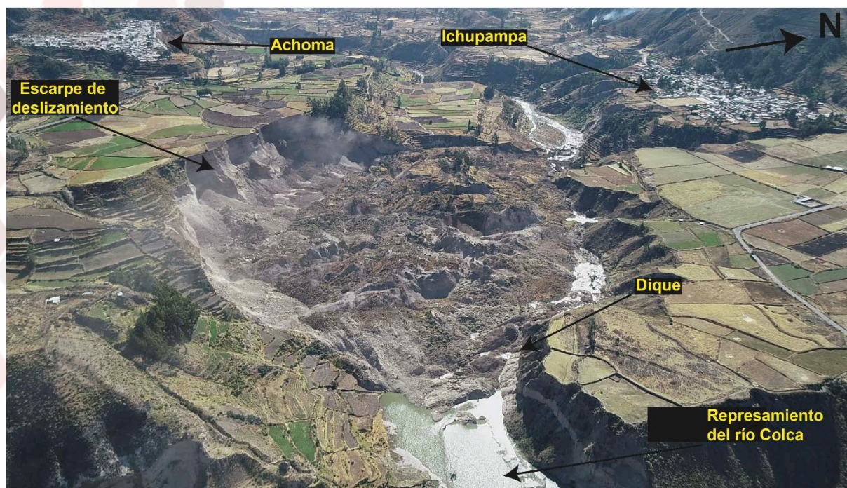
Figura 2. Imagen tomada con dron del deslizamiento de Achoma (vista al noroeste).
