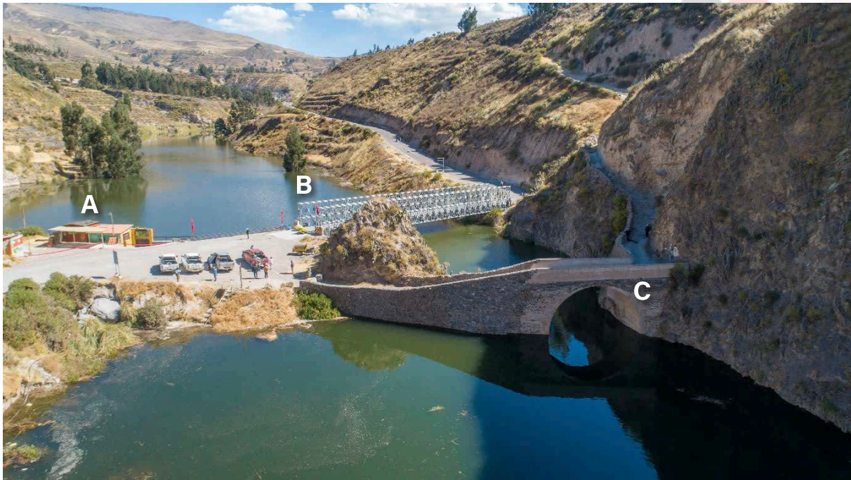
Figura 6. Infraestructura de los baños termales Chacapi afectada (A); puente vial metálico (B) y puente inca-colonial (C) que podrían verse afectados por el aumento del nivel de embalse (Foto Autocolca).
