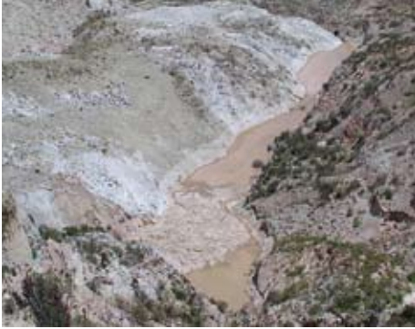
Figura A.13.4 Abanico aluvial producido por el colapso parcial del dique superior y depositado en represa inferior.
