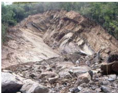
Figura 5.14 Deslizamiento traslacional en cuña gigantesca, en anticlinal fallado, areniscas cretácicas. K128 del ferrocarril Facativita-Utica, Departamento de Cundinamarca, Colombia (Fotografía y descripción de M. García L).
