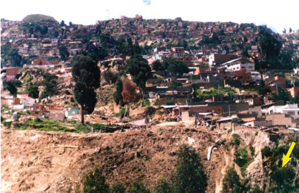
Figura A.7.2 Vista general de la margen izquierda (Sur Este) del deslizamiento de Cuarto Centenario. Al fondo se aprecia parte de la edificación del Colegio Pedro Bóveda que fue parcialmente destruido.
