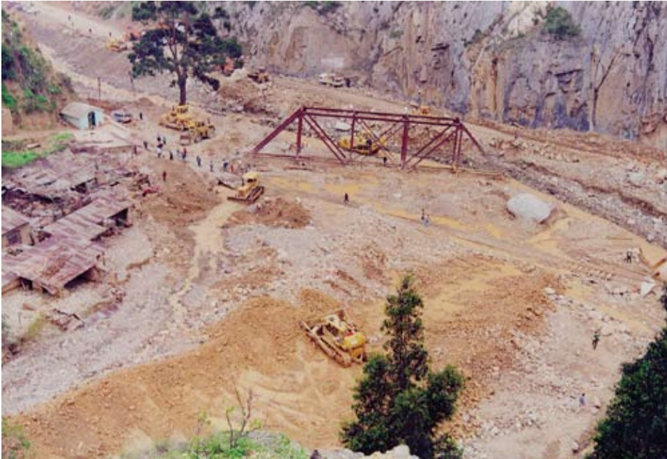
Figura A.22.2 Vista de la desembocadura de la quebrada Viso en el río Rímac. Se aprecia el puente de Ferrocarril Central, la línea férrea y la Carretera Central completamente sepultadas por el flujo (Fotografía L. Fidel, enero 1998).
