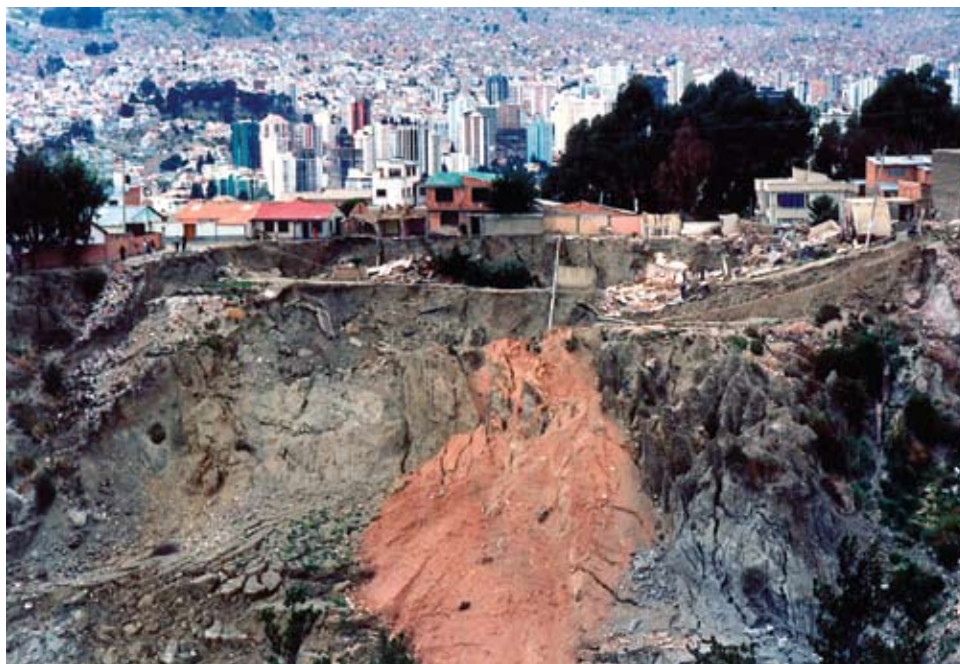
Figura A.5.5 Detalle del material deslizado al pie del talud en la zona de San Isidro.
