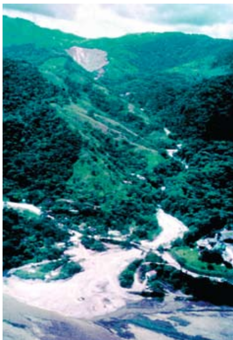
Figura A.15.4 Panorámica del sitio del Mirador tomada en un estado avanzado del proceso: al fondo se observa la cárcava en primer plano la zona de deyección de los flujos de detritos causados por la erosión. Solo después que se controló la erosión, fue posible controlar el enorme deslizamiento que involucró la carretera.
