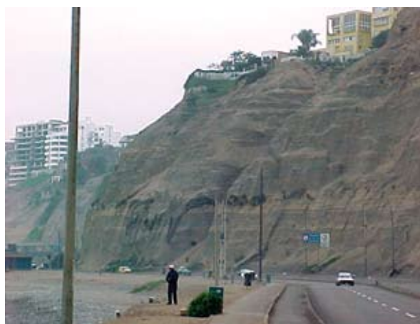
Figura 5.2 Acantilado, Distrito de Barranco, Lima, Perú (Fotografía J. Alva Hurtado, CISMID).
