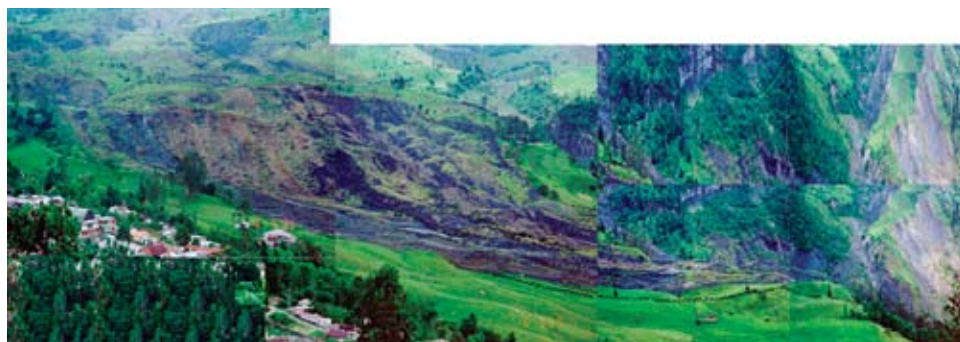
Figura A.24.1 Vista general del deslizamiento de San Cayetano en el departamento de Cundinamarca. A la izquierda el casco urbano del municipio.
