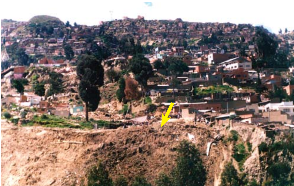
Figura A.5.4 Vista del segundo deslizamiento rotacional de San Isidro, que destruyó gran parte de las viviendas del sector. Se observa el desnivel y el hundimiento en la cabeza del deslizamiento rotacional. El material de color rojo, fue extraído de un banco de préstamo con el que se pretendía generar una cuña al pie del deslizamiento, trabajo que finalmente no se ejecutó debido al colapso total de la ladera.
