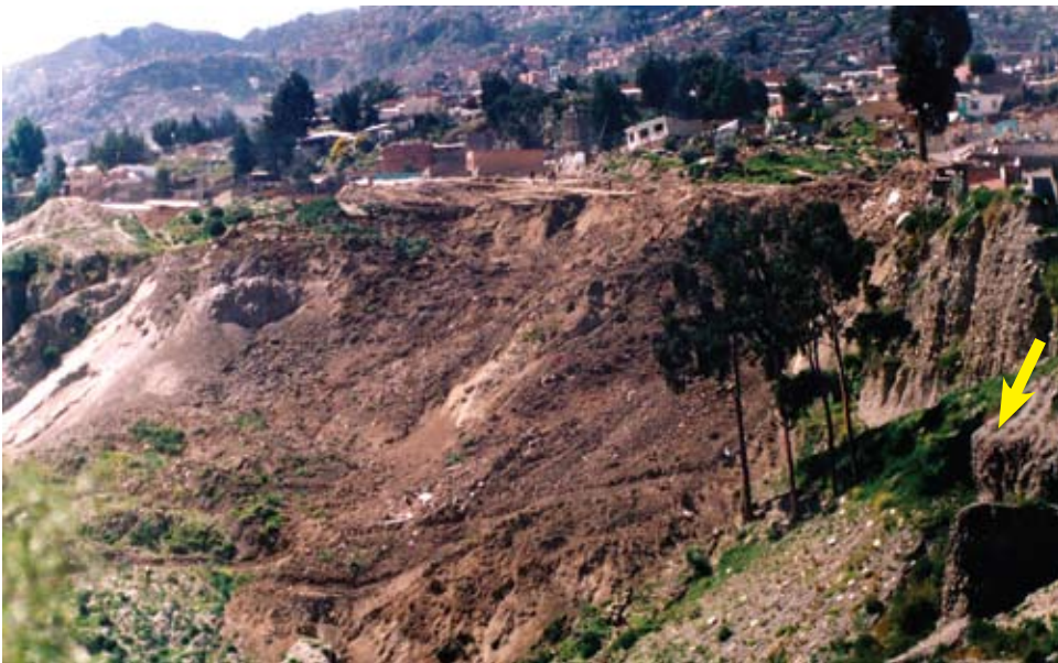
Figura A.7.3 Vista general del deslizamiento rotacional de Cuarto Centenario. Se observa la parte media del deslizamiento, donde las viviendas fueron totalmente destruidas. Se observa también el abrupto incremento de la pendiente hacia el pie del deslizamiento.
