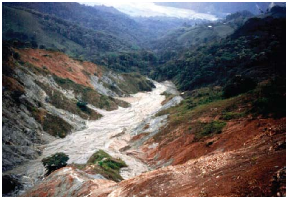
Figura A.15.7 Si se compara el estado de la ladera en 1971 (Figura A.15.2), con la situación en el año 2000, se puede tener una idea de la bondad de las obras de recuperación del sitio. Pero si se compara el costo de esta recuperación (11 millones de dólares) con el costo que hubiera tenido haber construido las obras de entrega controlada de las alcantarillas (US$ 20.000) salta a la vista la importancia de la prevención. Desafortunadamente en Sudamérica se tiene muy poca información sobre los costos directos e indirectos de los deslizamientos.
