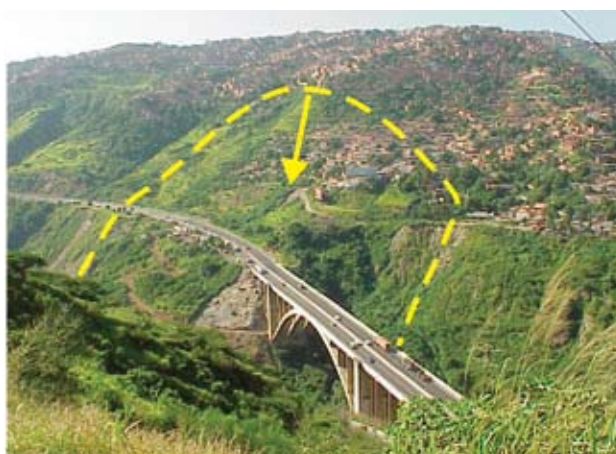
Figura A.4.3 Panorámica del lado Caracas del Viaducto No. 1, indicando los límites aproximados del macrodeslizamiento activo.
