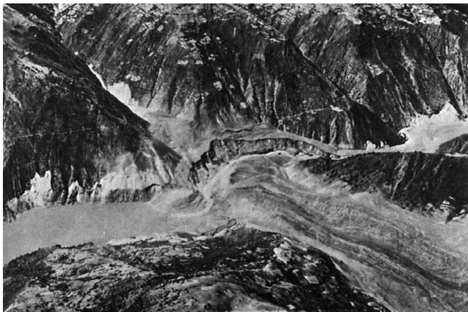
Figura A.10.5 Vista del lado este, margen izquierda del río Mantaro (quebrada Tinte), y el repesamiento originado por el deslizamiento (Fotografía S.A.N.).
