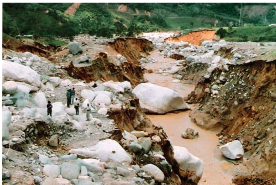
Figura A.20.6 Ensanchamiento y profundización quebrada La Arenosa.
