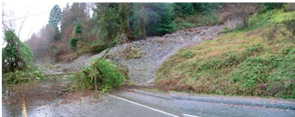
Figura 1.34 Deslizamiento por flujo en tilita glacial, desencadenado por alta presión de poros en enero de 2005. Cypress Road, West Vancouver, Canadá (Fotografía O. Hungr).
