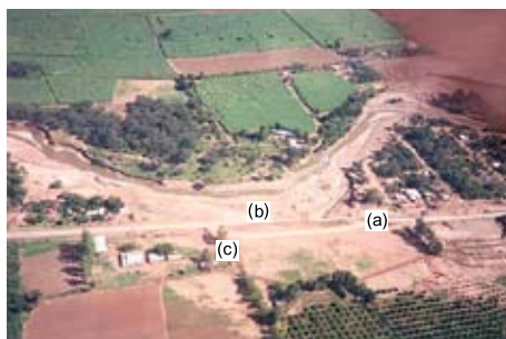
Figura A.21.7 Vista aérea. Detalle del punto de ingreso (a) del ramal principal del aluvión a Puesto Nuevo. Se comprueba la peligrosa cercanía de la traza de la ruta provincial número 6 (b) a la pendiente de corte del arroyo. Esta situación se repite con el canal de riego (c) de Puesto Nuevo.
