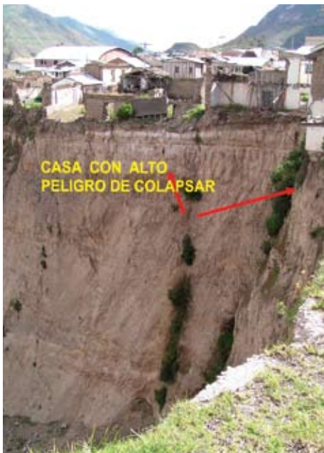
Figura A.11.4 Vista del escarpe principal del deslizamiento y viviendas en riesgo sobre la corona.
