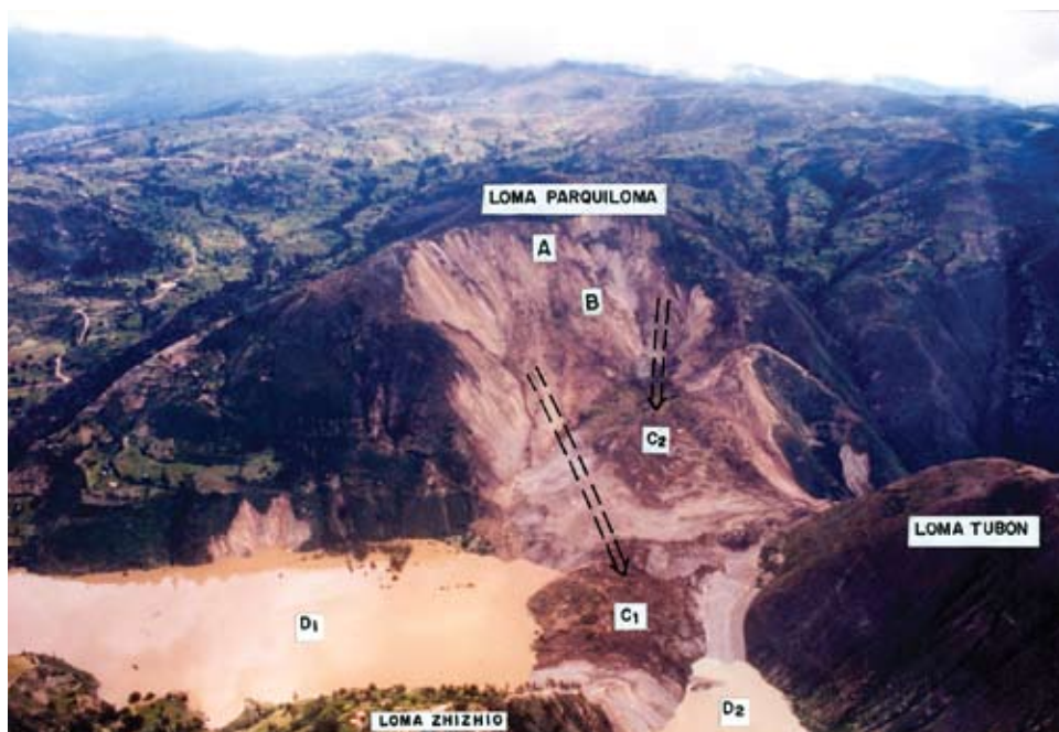
Figura A.17.5 El deslizamiento-represamiento de La Josefina (05-04-93): A, escarpe. C1, dirección y depósito del primer movimiento. C2, dirección y depósito del segundo movimiento. D, embalses (1) río Paute, (2) río Jadán (Tomado de Zevallos et al, 1996).
