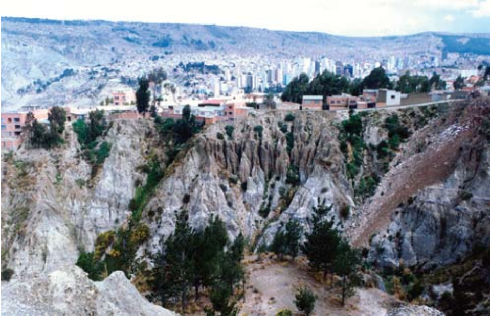
Figura A.5.1 Vista general de la calle Donoso Tórrez en la zona San Isidro, antes del primer deslizamiento. Se observa la intensa erosión en los depósitos de grava, los cuales delimitaron el plano de rotura. La erosión diferencial desarrolló altas pirámides de gravas que por la fuerza de la gravedad arrastraron el resto de los materiales y viviendas.
