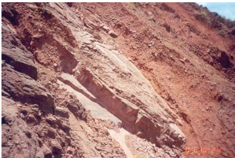
Figura A.9.3 Detalle del movimiento traslacional controlado por la estratificación de la roca arenisca.
