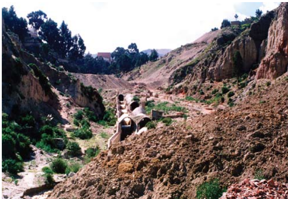
Figura A.7.6 Detalle de la zona de acumulación del deslizamiento rotacional de Cuarto Centenario. Al fondo se observan los dos cañones del embovedado del río Orkojahuirá que estaban siendo construidos.
