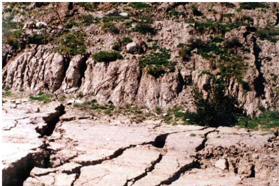
Figura A.7.1 Detalle de las grietas radiales al pie del deslizamiento en la zona de acumulación.
