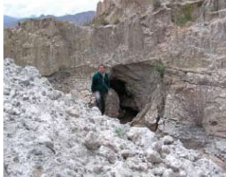
Figura A.13.5 La formación del túnel previno el colapso del represamiento que probablemente hubiera ocurrido al colmatarse la laguna.
