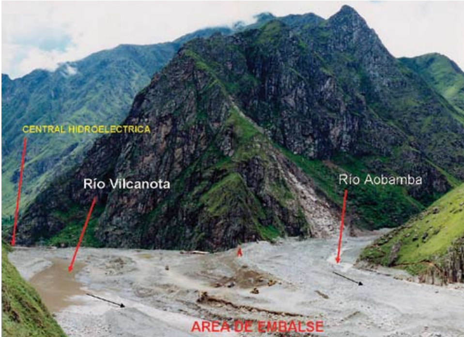
Figura A.25.3 Vista del represamiento del río Vilcanota – Urubamba. A la derecha el río Aobamba. Aguas arriba, en el río Vilcanota, se ubica la Central Hidroeléctrica de Machu Picchu que fue parcialmente destruida por el flujo de detritos (aluvión).
