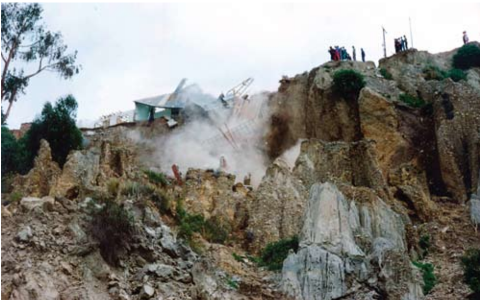
Figura A.5.2 Momento cuando se producía el primer deslizamiento, es notable la altura y verticalidad del talud.
