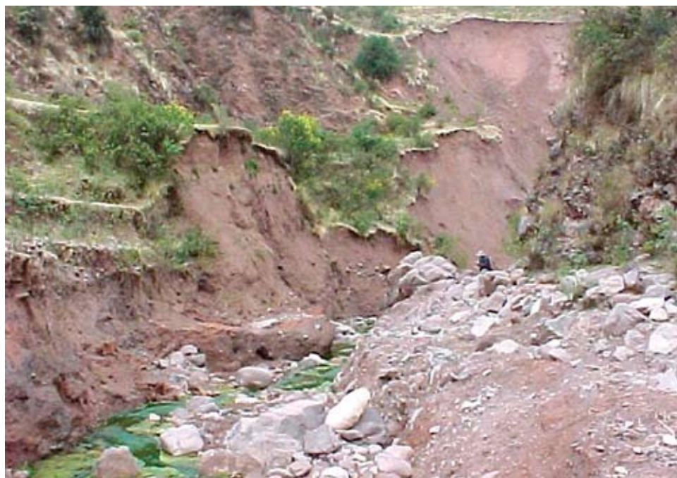
Figura A.9.4 Cauce del río Huancaro aguas arriba del sitio de deslizamiento de Huamancharpa en donde se notan varios deslizamientos expuestos a la erosión del río.
