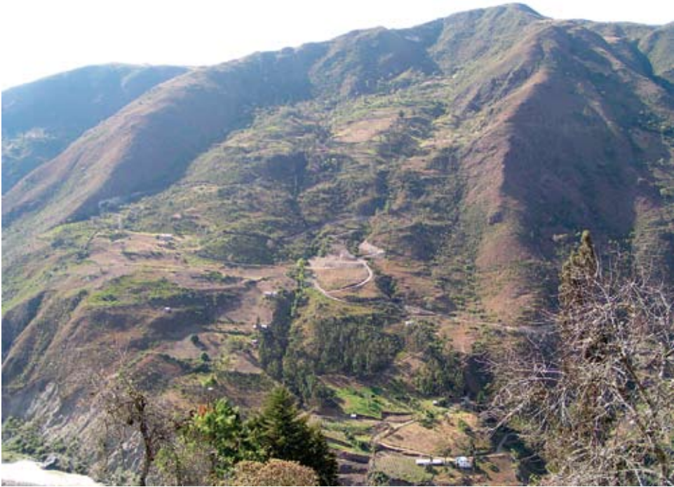
Figura 1.16 Deslizamiento rotacional, Cerro Mizhquiyacu, Ecuador, 1993.
