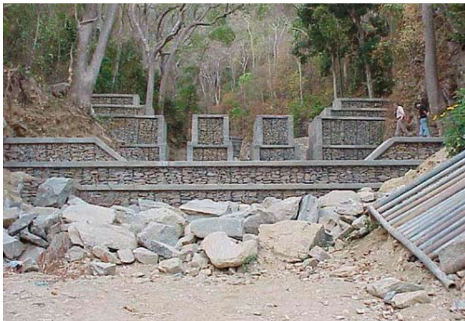
Figura B.2.18 Presa abierta de gaviones revestidos con concreto. Presa Las Comadres, afluente de la quebrada Piedra Azul.
