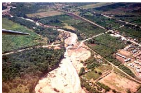
Figura A.21.6 Vista aérea del puente de Palma Sola. Aguas arriba (hacia el observador) aparece la zona que albergó una efímera laguna por endicamiento. También se ve el puente tipo Bailey construido para salvar el obstáculo representado por el arroyo Santa Rita.
