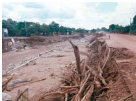
Figura A.21.10 Vista de la cárcava, que muestra sus altas escarpas de erosión y los daños en la ruta provincial número 6.
