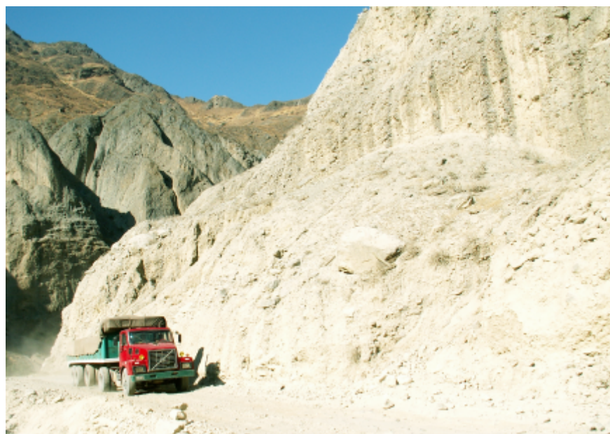
Foto 10.10 Sector de la carretera Sayán-Churín, donde constantemente se producen derrumbes en tiempos de lluvias.
