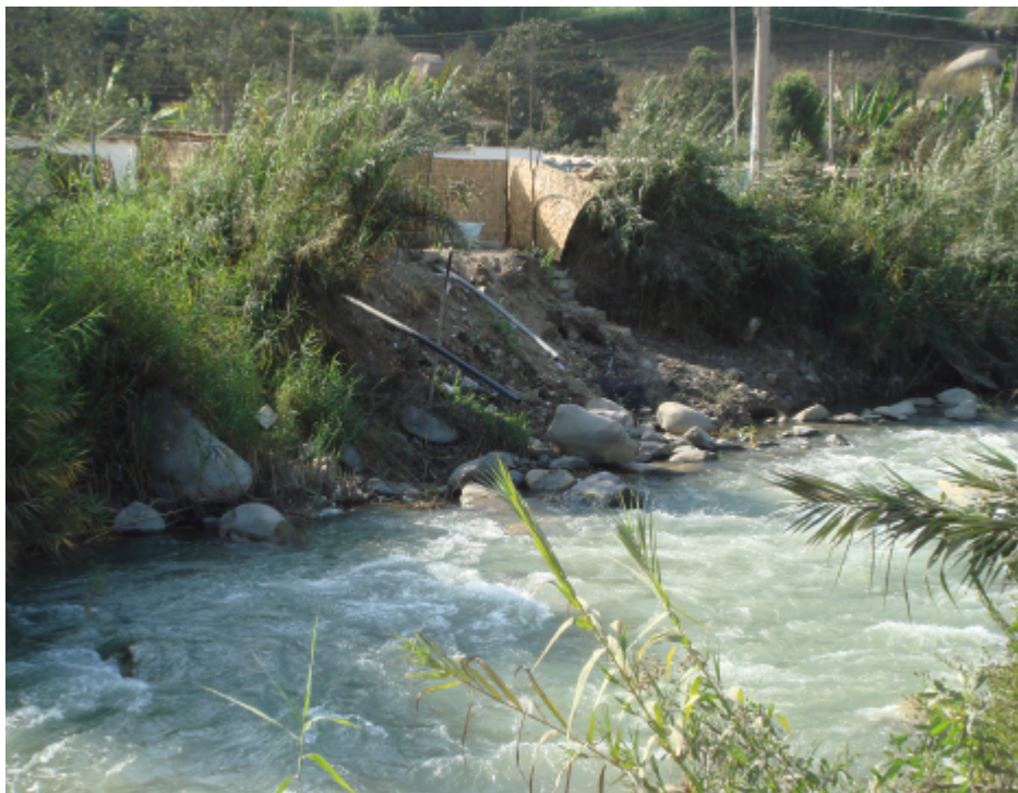
Foto 10.12 Margen derecha río Huaura, aguas abajo de Sayán. Obsérvese desagües que vierten desechos directamente al río.
