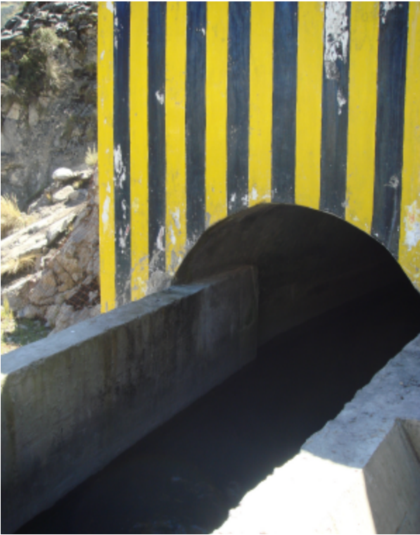
Foto 9.3 Desagüe mina Uchuchacua, sector Patón, estación 22jw-020b, sulfatos: 111ug/l, 41ug/l de As, 61ug/l de Sb y 163 ug/l de Zn.
