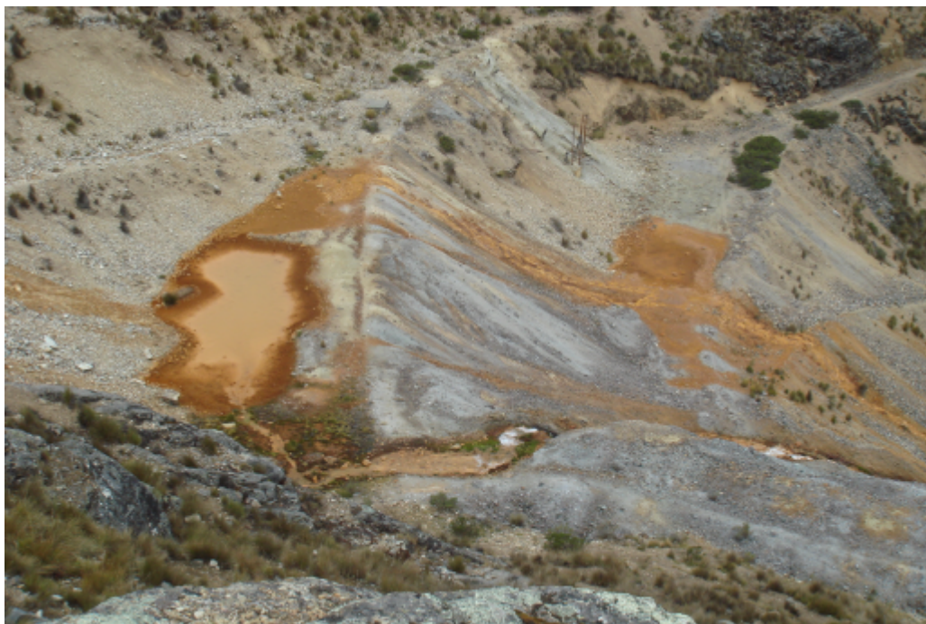
Foto 10.5 Una de las 21 canchas de relave de la mina abandonada Santa Rita. Obsérvese el drenaje ácido de mina liberado.
