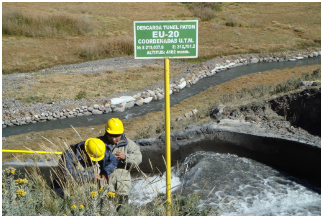
Foto 10.4 Estación de descarga en las nacientes de la quebrada Patón, aguas abajo de la descarga del canal que bordea la laguna del mismo nombre.
