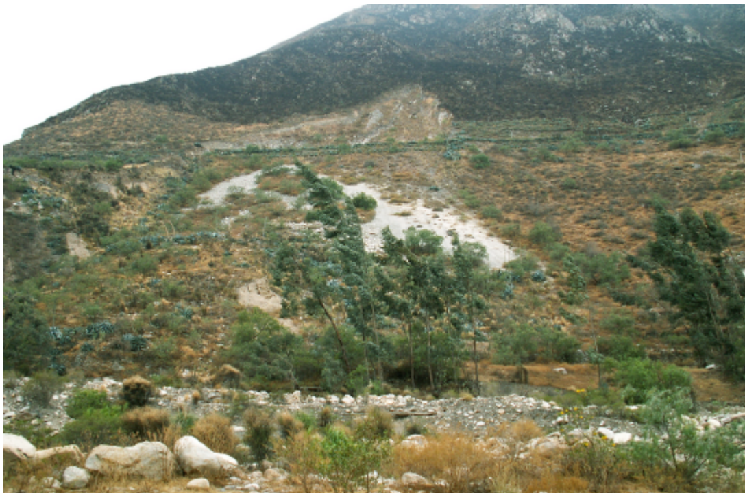
Foto 7.6 Derrumbe-flujo en la margen izquierda del río Huaura, a la altura del cerro Toldo Rumi (Oyón).
