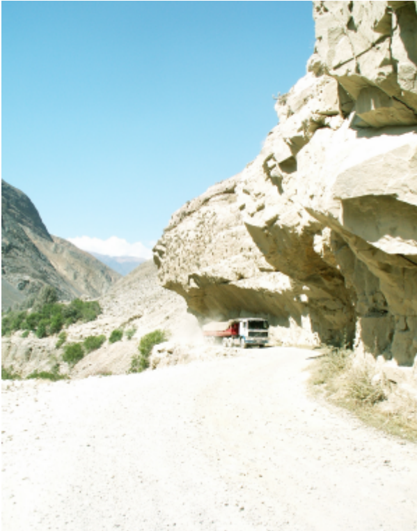
Foto 7.1 Caída de rocas. Carretera Sayán-Churín.
