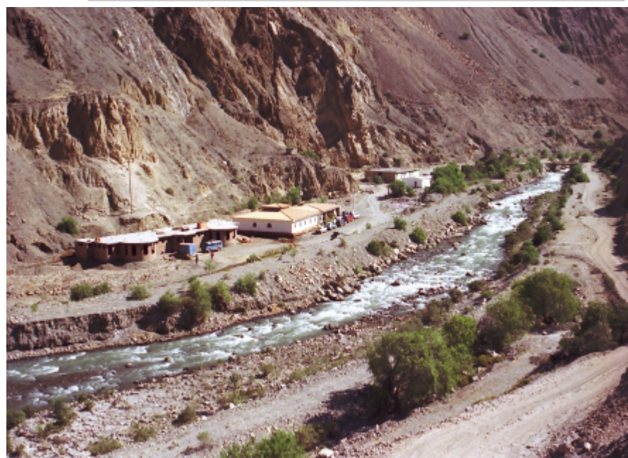
Foto 7.8 Erosión fluvial en el sector Cabracancha (distrito de Andajes). Obsérvese el arrimado de material en la margen derecha del río Huaura para proteger la zona de los baños termales.
