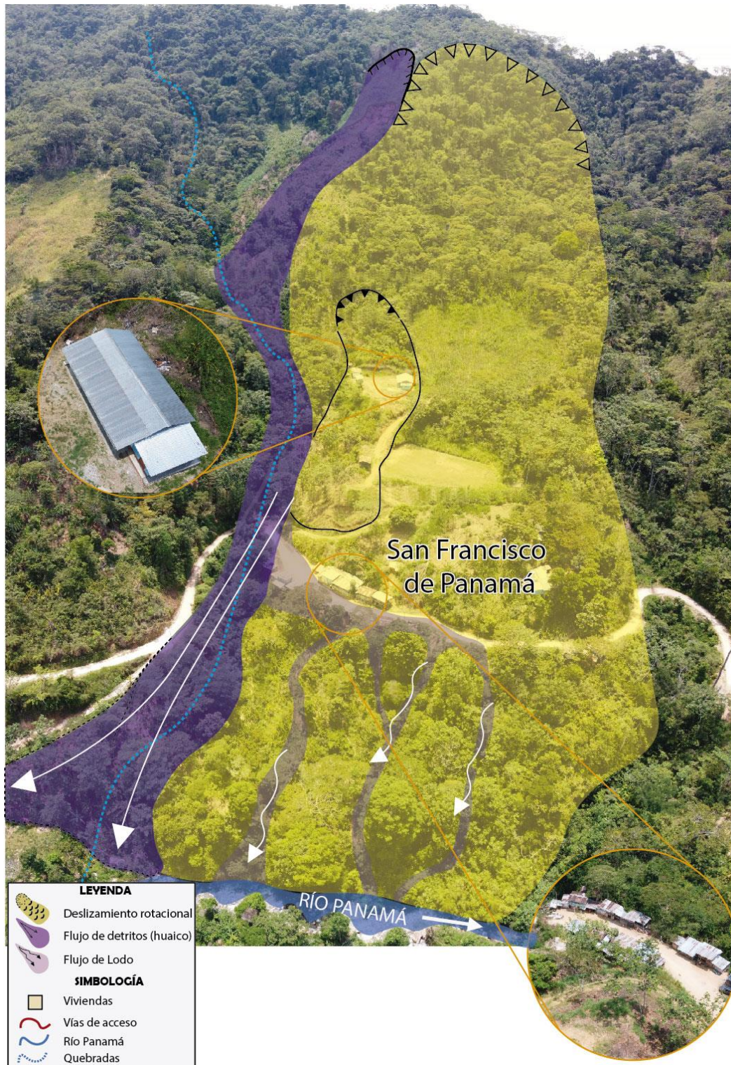
Figura 16. Vista panorámica con dron (tomada el 2020), de los peligros geológicos (Deslizamientos y flujos), que afectan al poblado de San Francisco de Panamá, donde las líneas en color blanco representan la dirección del flujo (detritos y lodo).
