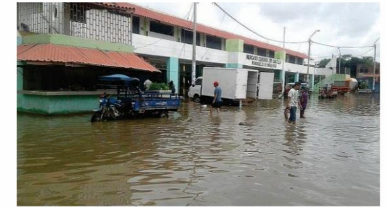
7. Inundación en el mercado central de Castilla, el agua alcanzó los 0,30 m de altura (Foto: web).
