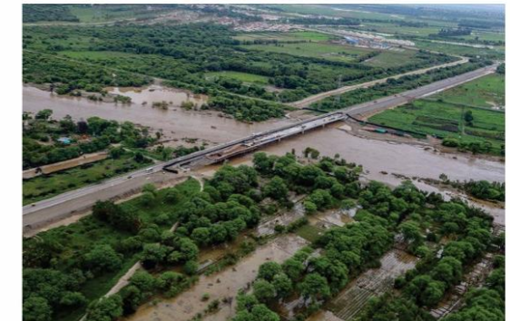
8. Puente sobre el río Piura en la Panamericana Norte, se puede observar la inundación hacia ambas márgenes que afectó terrenos de cultivo (Foto: web.).
