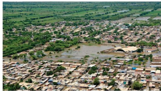
2. Inundación en el extremo norte de la ciudad de Catacaos, produjo la caída de muros de concreto (foto web).
