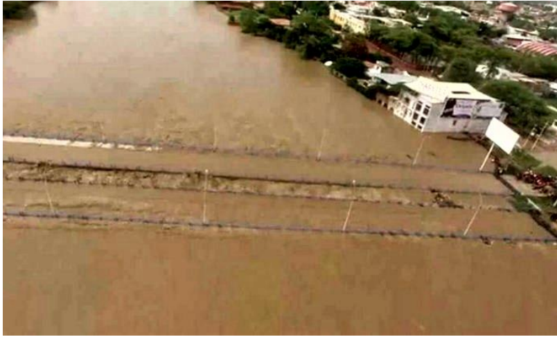
Foto 12: Vista aérea donde se puede apreciar los reboses por encima del puente Andrés Avelino Cáceres (Foto: diario La República).
