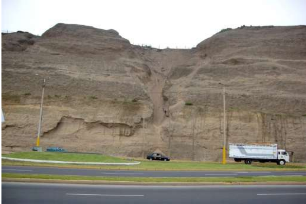
Fotografía 5.7 Zona crítica 268: Erosión de ladera y derrumbes en Acantilados de la Costa Verde (Magdalena del Mar), en la provincia de Lima
