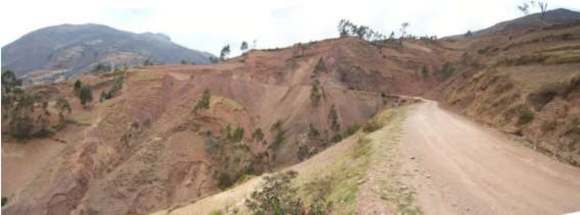
Fotografía 3.2. Zona crítica 26: Deslizamiento y derrumbes del sector Quisqui, en la provincia de Ambo. Afecta dos desarrollos de carretera, tres viviendas y terrenos de cultivo.
