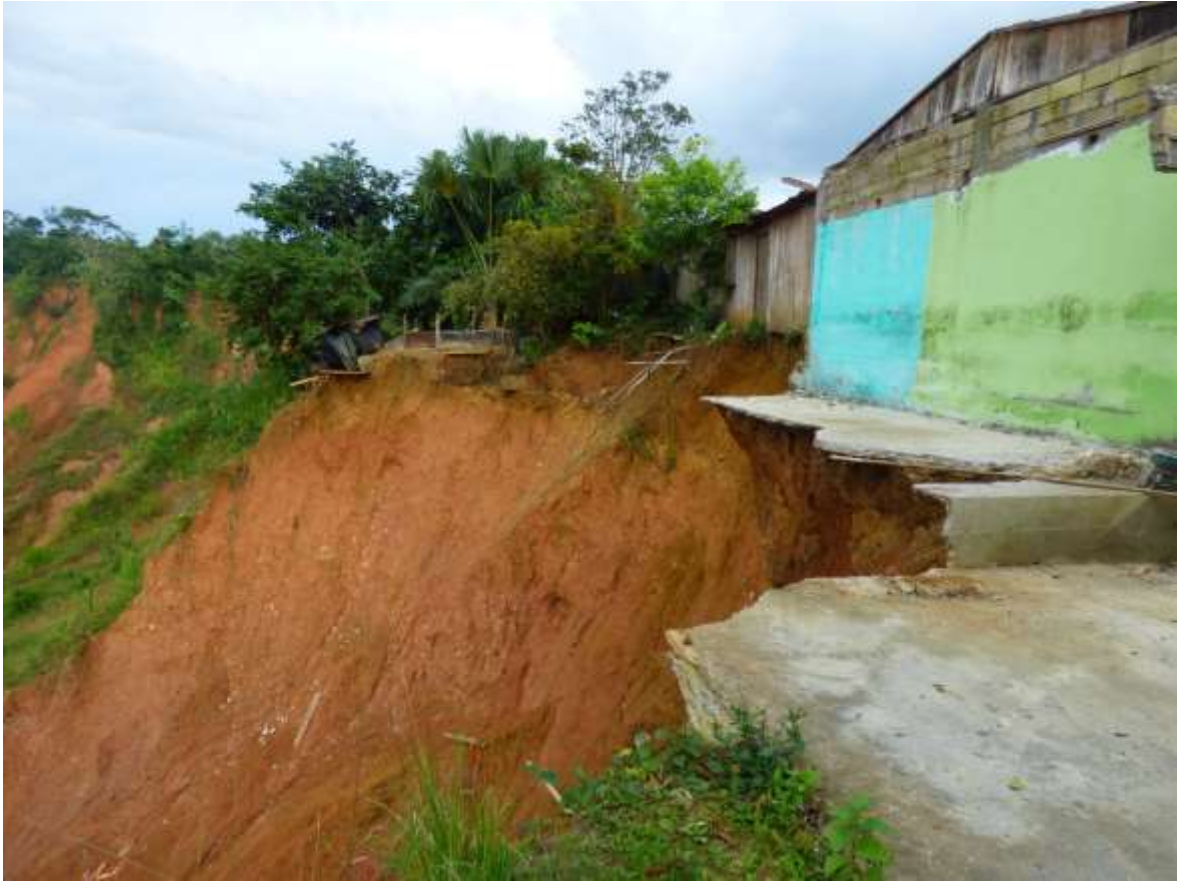
Fotografía 3.3. Zona crítica 52: Deslizamiento, derrumbe, flujo de detritos, erosión de ladera en el sector Las Vegas, (Daniel Alomia Robles), en la provincia de Leoncio Prado. Afecta viviendas, tramo de carretera y cultivos
