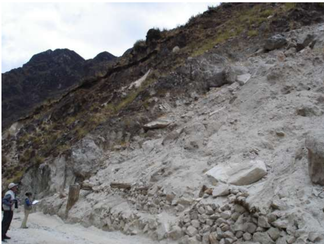
Fotografía 2.5. Zona crítica 93 “Deslizamientos y derrumbes en sector Cerro Huachaper /carretera hacia laguna Pelagatos (Pampas), en la provincia de Pallasca. Afecta 150m de carretera
