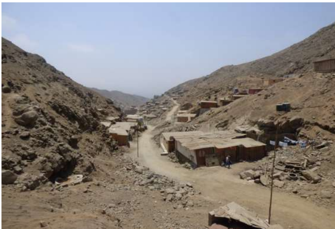
Fotografía 5.9 Zona crítica SJ-18: Flujo de detritos en AAH.HH Cangallo (San Juan de Lurigancho), en la provincia de Lima
