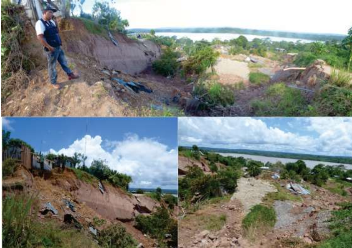
Figura 4.1. Zona crítica 51: Deslizamiento en el sector Villa Junín, en la margen izquierda del río Tambo, en la provincia de Tambo.
