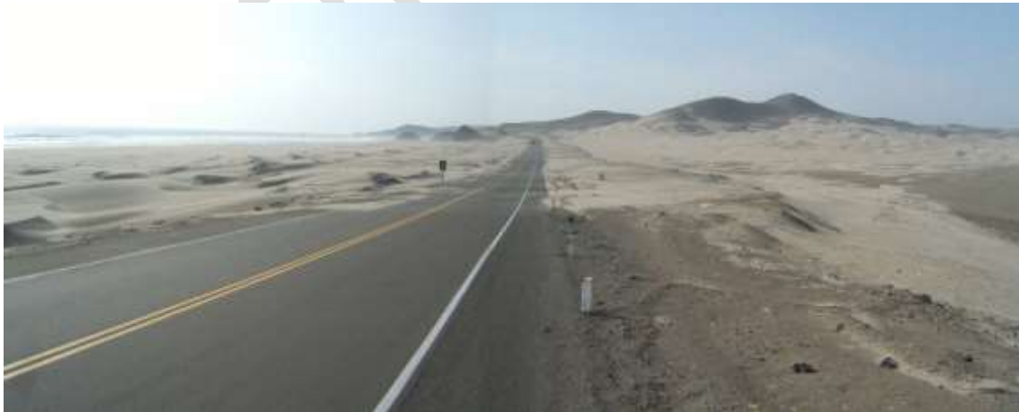
Fotografía 2. 4. Zona crítica 83: Arenamiento y campo de dunas en sector Pampa Gramadal km 252-253; km 254 de la Panamericana Norte (Huarmey), en la provincia de Huarmey. Ocasiona obstrucción de carretera y tránsito
