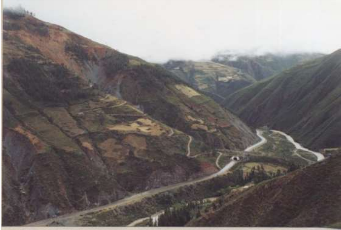
Fotografía 3.1. Zona crítica 4: Deslizamiento y/o deslizamiento-flujo. Asentamientos de tierras del poblado San Juan de Cashayo(San Rafael), en la provincia de Ambo.
