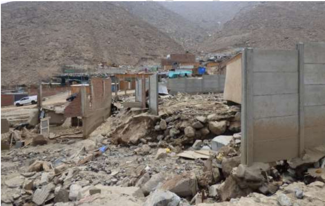
Fotografía 5.2 Zona crítica CI-1: Vista de viviendas destruidas por el flujo de detritos de Río Seco
