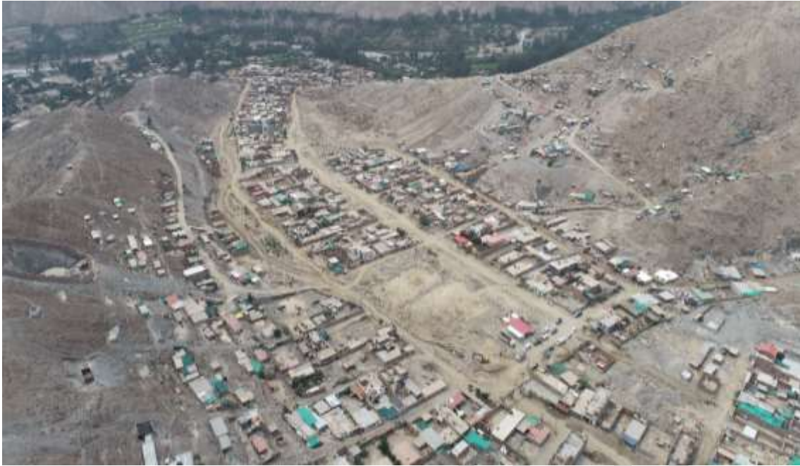
Fotografía 5.1 Zona crítica CI-1: Vista panorámica de la quebrada Río Seco, viviendas se encuentran sobre el cauce de la quebrada, el flujo del 12/03/2023 arrasó con viviendas que se encontraban a su paso.
