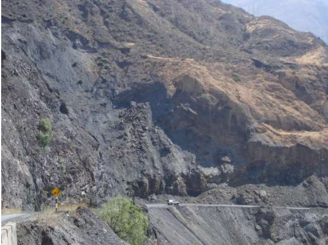
Fotografía 2.3. Zona crítica 55: Caída de rocas y derrumbes en la carretera Caraz-Huallanca “Cañón Pato” (Huallanca), en la provincia de Huaylas. Afecta diversos tramos de la carretera Caraz- Huallanca, túneles y demás.
