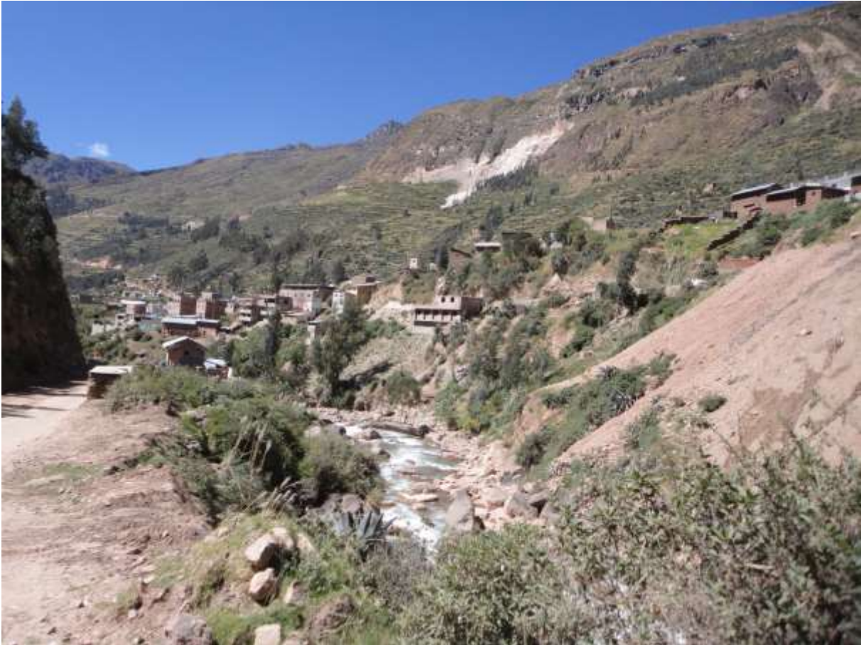
Fotografía 6.1. Zona crítica 2: Derrumbe y flujo de detritos en el sector Yanahuanca (Yanahuanca) en la provincia Daniel Alcides Carrión. Afecta el poblado que se encuentra en un depósito antiguo
