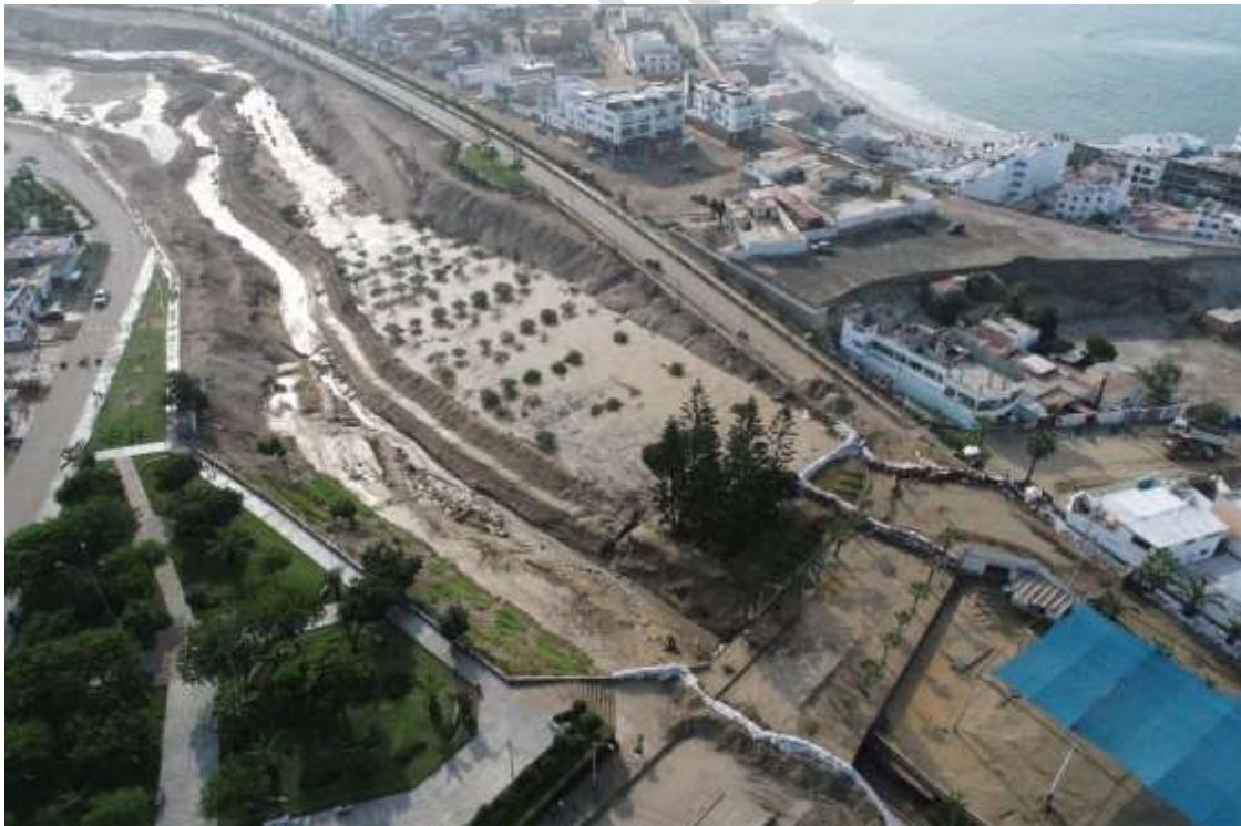
Fotografía 5.4 Zona crítica 285: Vista del depósito del flujo de lodo en la quebrada Malanche (Río Seco), debido a la reducida luz del puente, discurrió por encima produciendo el colapso del muro del Complejo Deportivo de la Municipalidad Distrital de Punta Hermosa, afectando a su paso, vías y viviendas en ambas márgenes de la quebrada.
