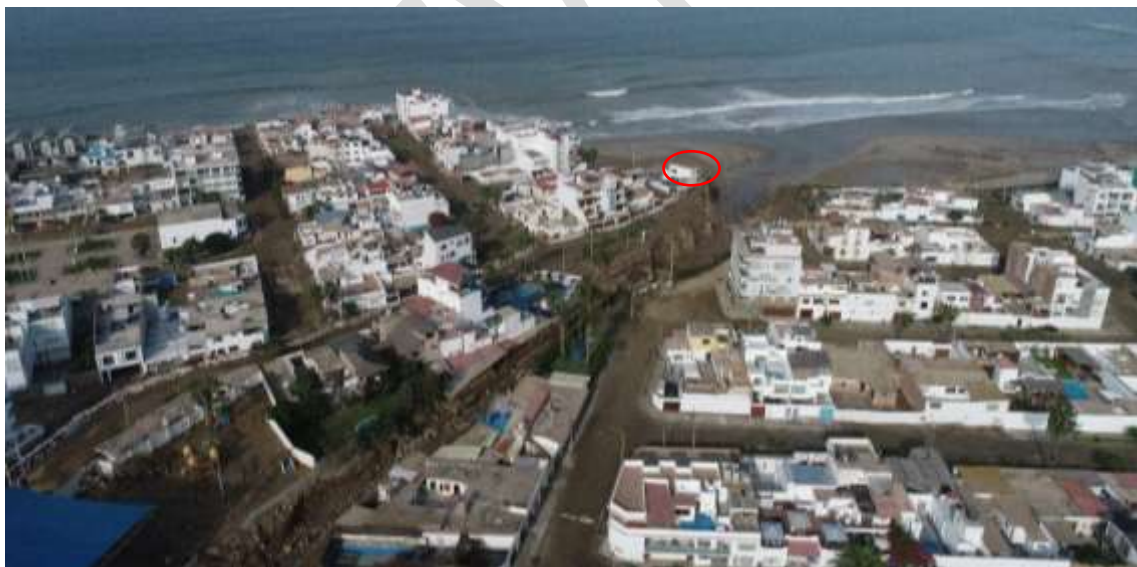
Fotografía 5.6 Zona crítica 285: Vivienda del Balneario de Punta Hermosa se encuentran cerca del borde del acantilado a punto de colapsar por la socavación del pie del acantilado y erosión en forma de cárcavas.
