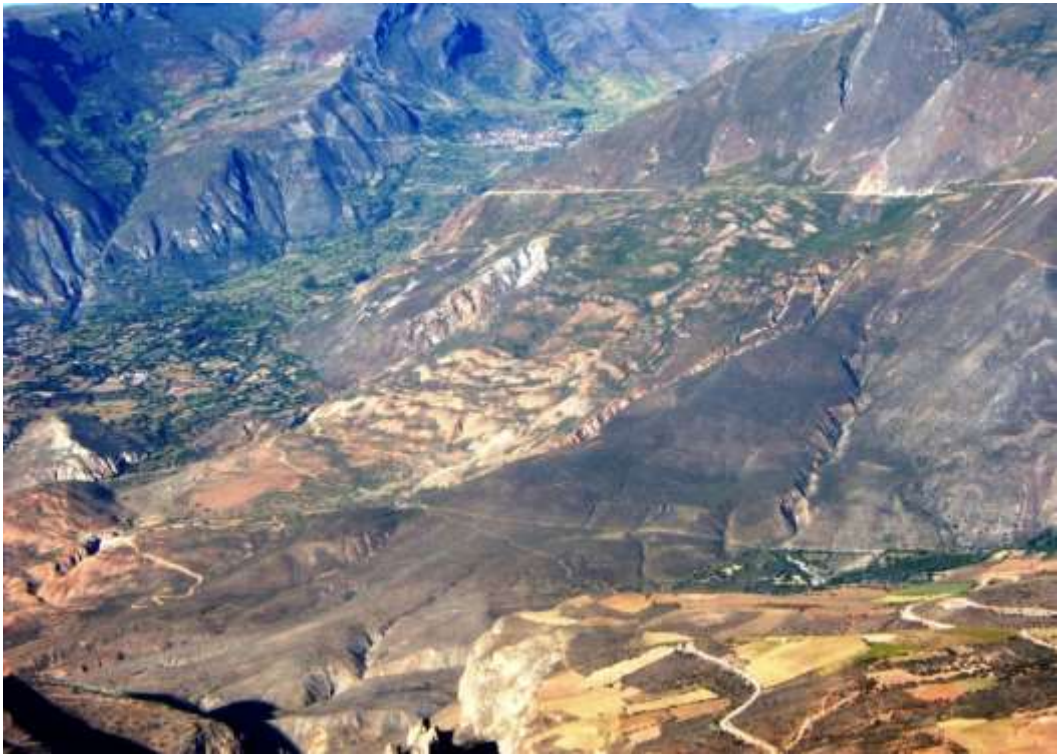
Fotografía 2.1. Zona crítica 4: Deslizamiento rotacional y cárcavas en el sector del cerro San Cristóbal (Paucas) en la provincia de Antonio Raymondi. Afecta carretera y terrenos de cultivos
