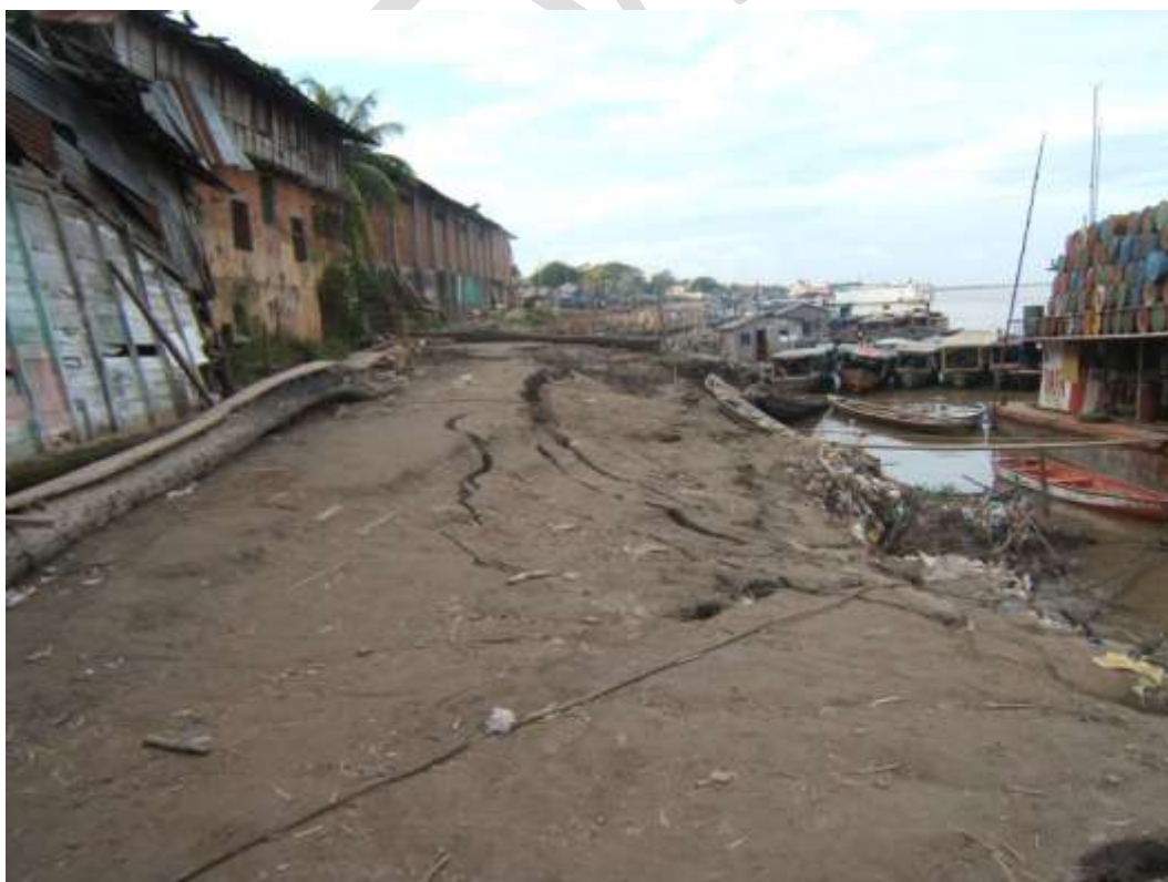
Fotografía 7.1. Zona crítica 12: Erosión fluvial en Puerto Pucallpa (Calleria) en la provincia Coronel Portillo.
