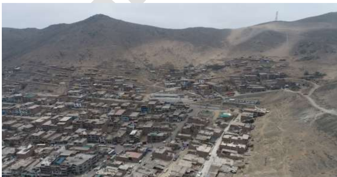
Fotografía 5.10 Zona crítica SA-1: Arenamiento y caída de rocas en Asociación Virgen de las Nieves (Santa Anita), en la provincia de Lima
