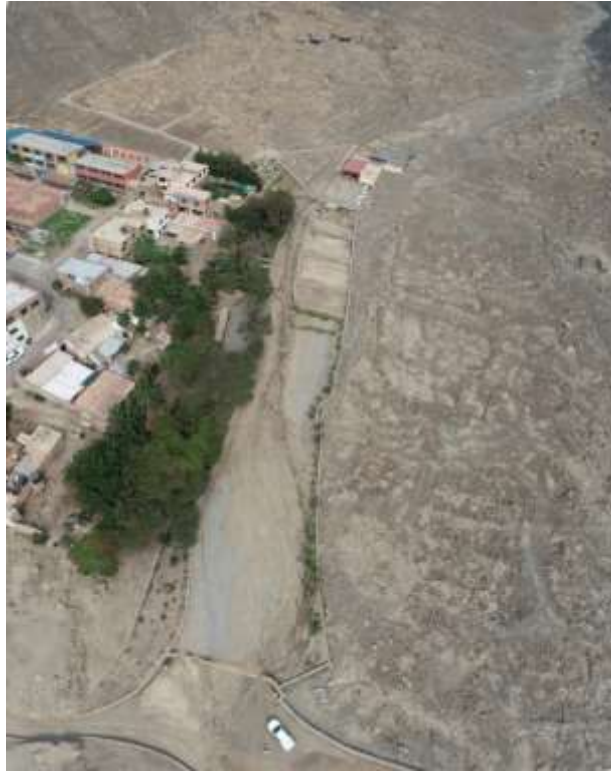
Fotografía 5.3 Zona crítica CI-1: Flujo d detritos en la quebrada Huaycán afectó instalaciones del Centro Arqueológico de Huaycán.
