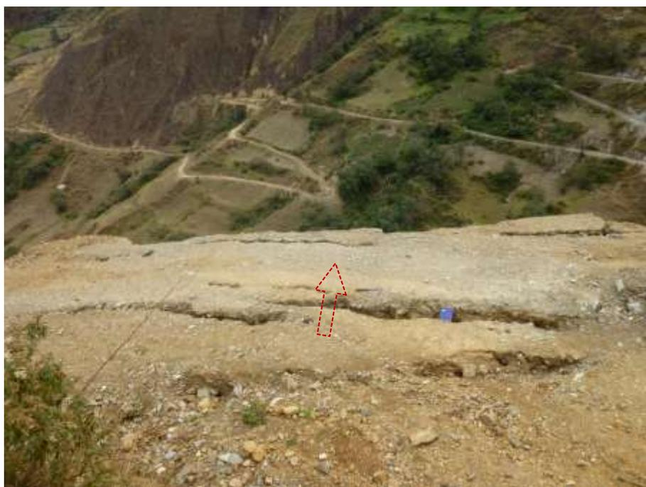
Foto 10: Se observan las grietas en la carretera con aperturas hasta 0.4 m y la flecha roja muestra la dirección del movimiento del terreno.
