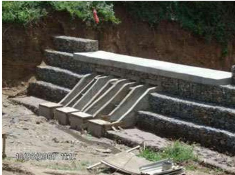
Modelo de una presa de retención abierta ranurada
