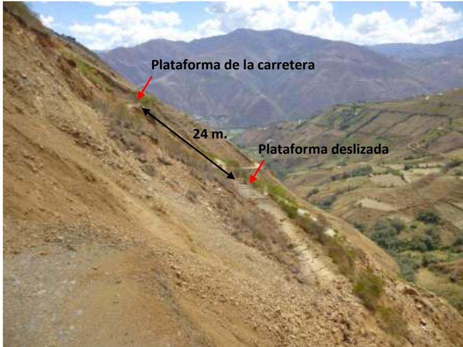
Foto 08: Se observa la destrucción de 90 m de la carretera, también se puede ver el desplazamiento de 24 m, siendo ya parte de la masa deslizada.
