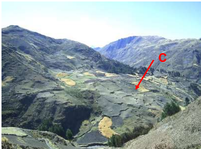
Foto N° 20: Vista del Deslizamiento de Jato, (C) cuerpo del deslizamiento que represo la quebrada Shongo.
