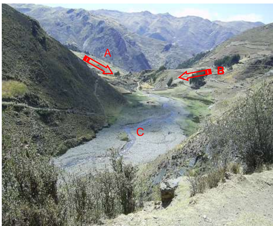
Foto N° 16: Vista de los deslizamientos - flujos del Cerro Mohupunta (A) y Pumacancha (B), que originaron el represamiento de la quebrada Shongo (C).
