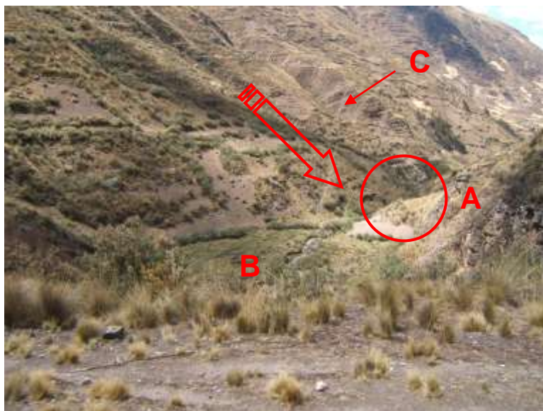
Foto N° 28: Pié del deslizamientos del Cerro Huellac, obsérvese la zona de represada por el deslizamiento en la quebrada Chico (A), parte de la laguna formada (B) y la fuerte erosión en cárcavas del cuerpo del deslizamiento (C).
