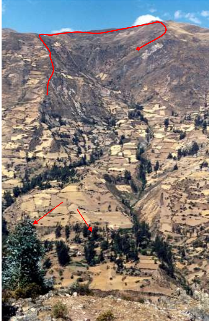
Foto 32: Deslizamiento – flujo de detritos estabilizado de Cruz Jircan
