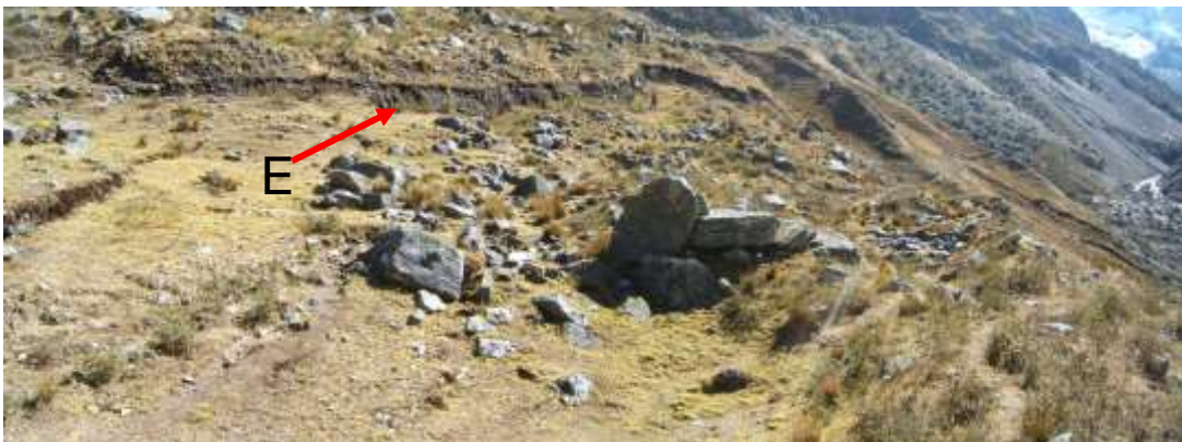
Foto N° 22: Deslizamiento activo en el sector Milluatacsha, que afecta morrenas; nótese la escarpa del deslizamiento (E) con salto entre 1 y 3 m.
