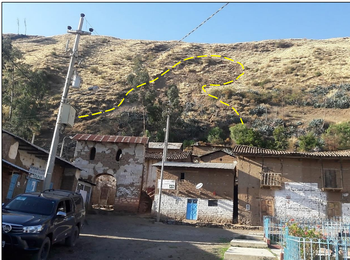
Foto 4: deslizamiento superficial al sur de Tulpay.
