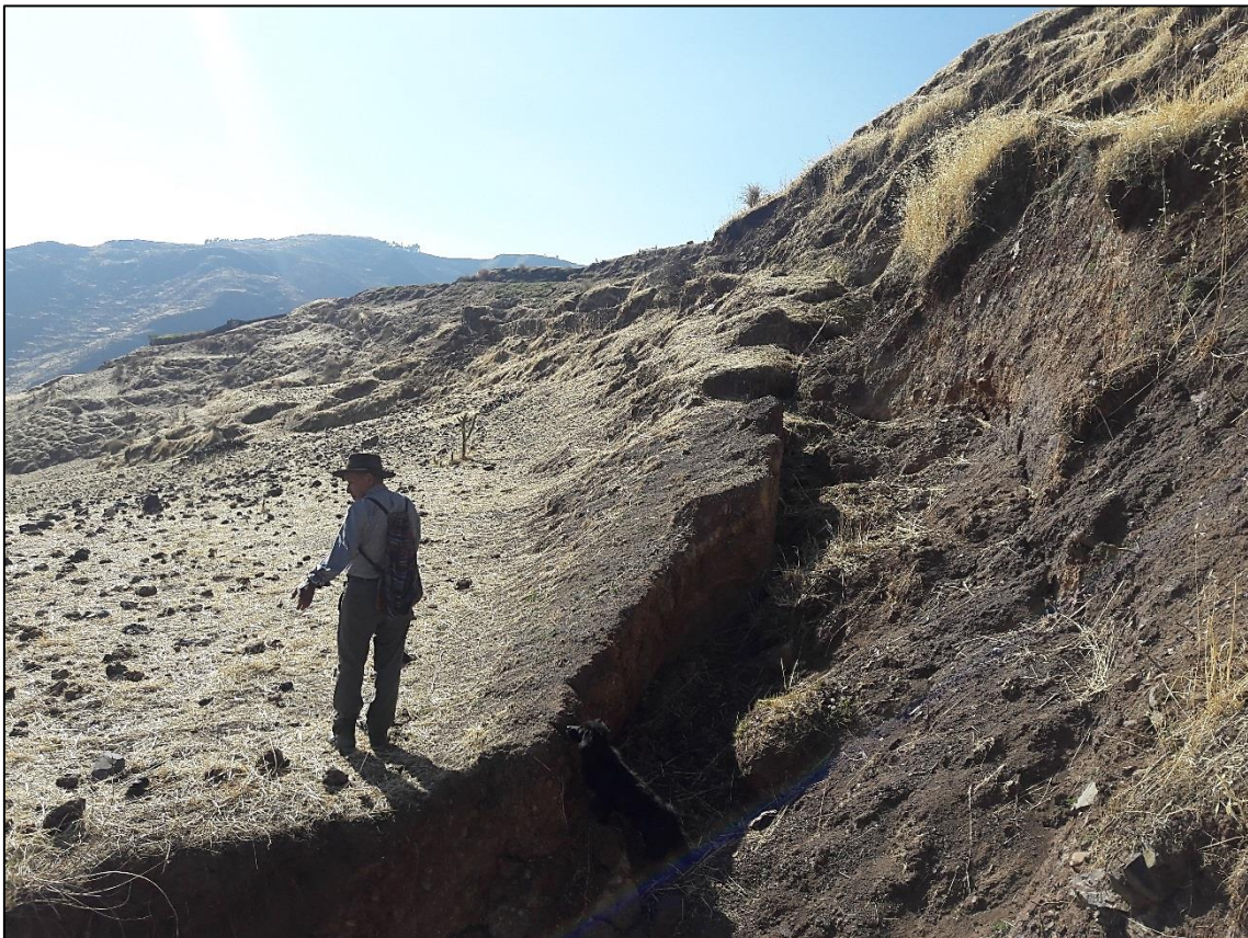
Fotos 9 y 10: escarpe principal del deslizamiento activo de Tulpay.
