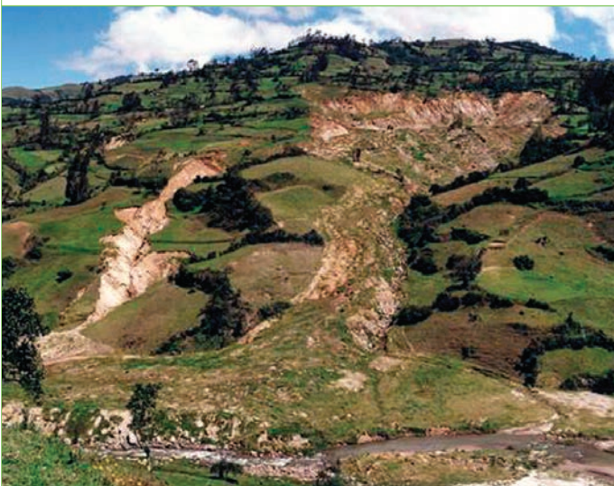
Deslizamiento de Calquis, arrasando viviendas y terrenos de cultivo, San Miguel de Pallques, Cajamarca.
