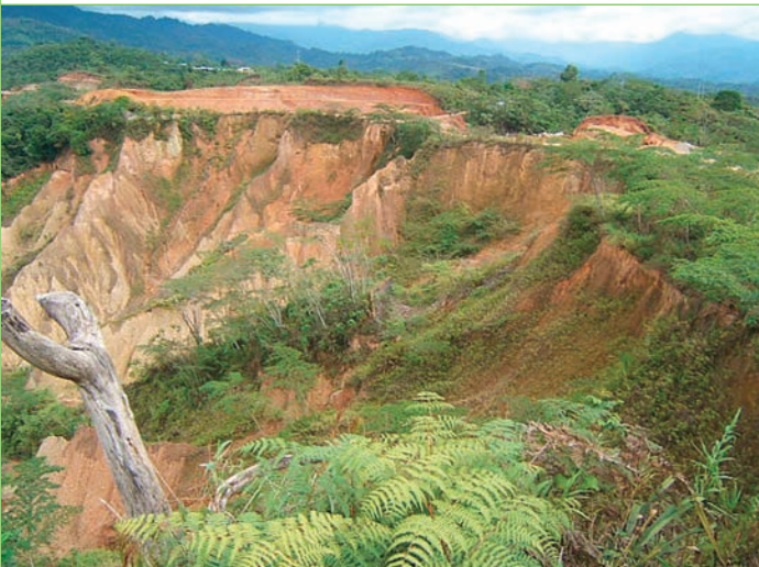
Deslizamiento Las Vegas, carretera Tingo María-Pucallpa.
