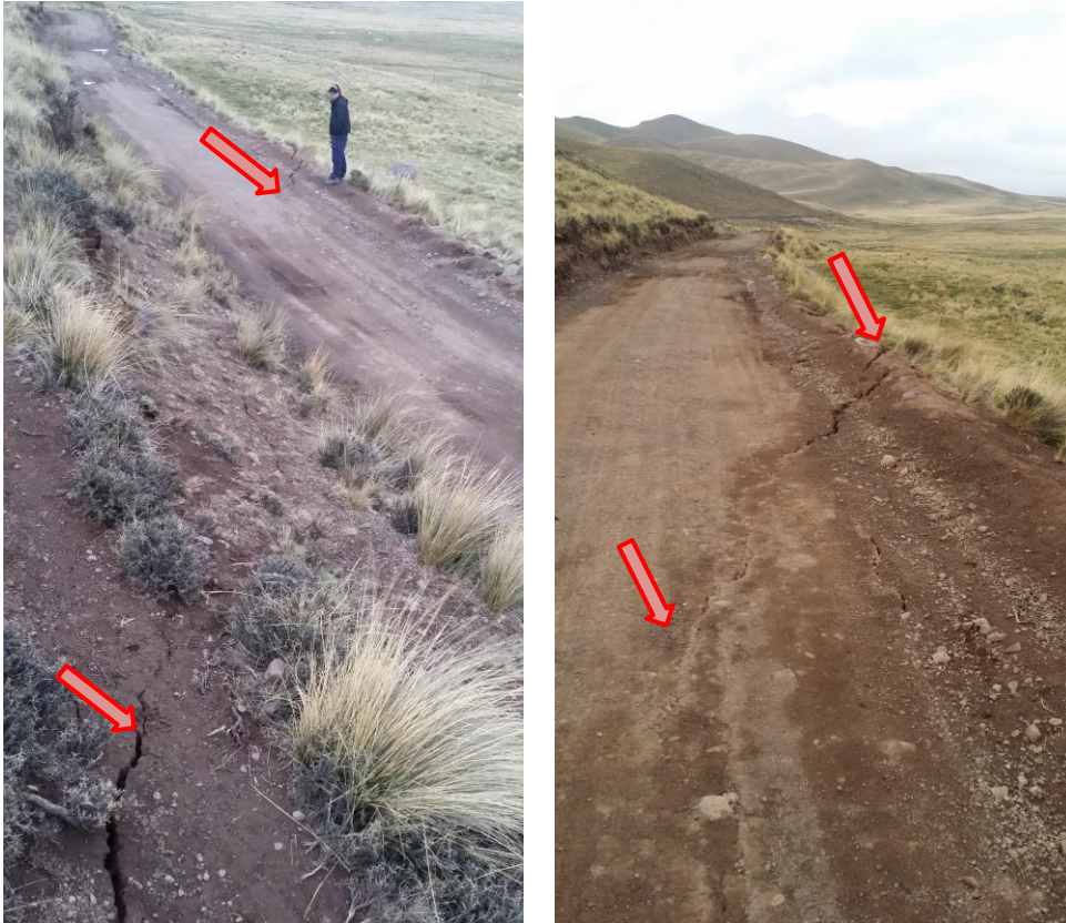
Foto 03: Grietas en el terreno y carretera generadas por el sismo del 01 de diciembre, llegando a presentar abertura de hasta 10cm.
