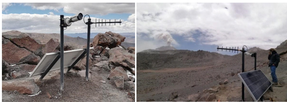
► Fig. 4- Estructura metálica ligera transportable, instalada en la estación SHUA que conforma la red de monitoreo del volcán Sabancaya.
