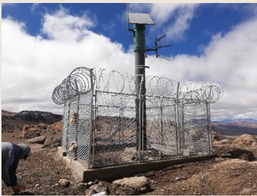
► Fig. 1 - Estación repetidora de transmisión que conforma la red de monitoreo del volcán Sabancaya.
