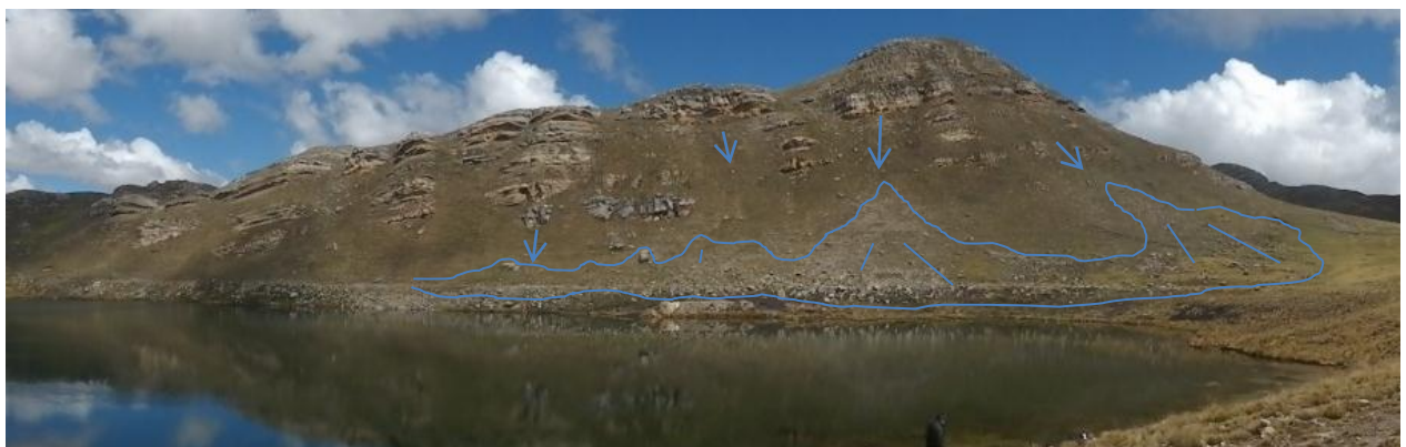
Foto 10. Vista de la laguna Negro Bueno se aprecia en la ladera pequeñas caídas de rocas (caída por vuelco de los estratos de calizas de la Formación Pariatambo) que generan pequeñas acumulaciones coluviales al pie de la laguna. Se distingue además el nivel aparentemente inferior de la laguna.
