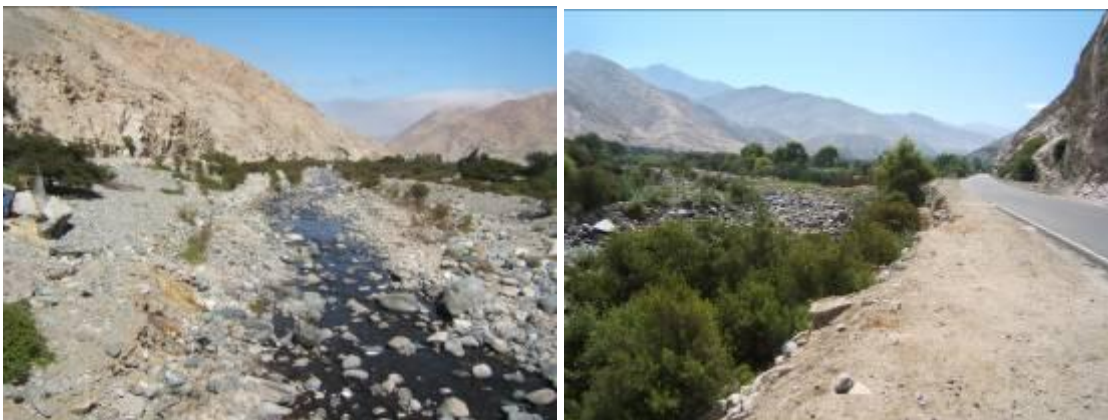
Foto 59 Dos sectores del río Fortaleza (sector Huaquish), donde se producen procesos de erosión fluvial que pueden comprometer tramo de la carretera Pativilca-Conococha.
