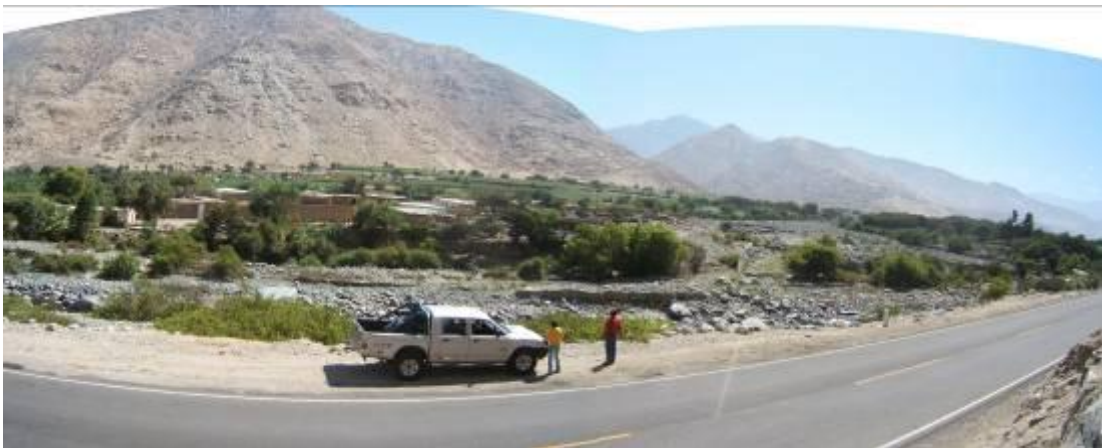
Foto 41 Vista del sector de Huaquish afectado por flujo de detritos de la quebrada Patap; en el mismo sector erosión fluvial.
