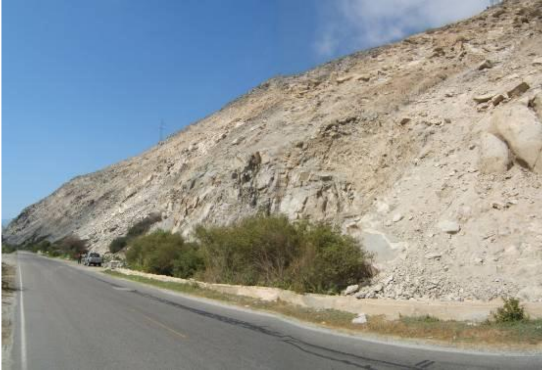
Foto 30 Laderas susceptibles a derrumbes en el sector de Huancar Alta Km 39 Pativilca-Conococha)
