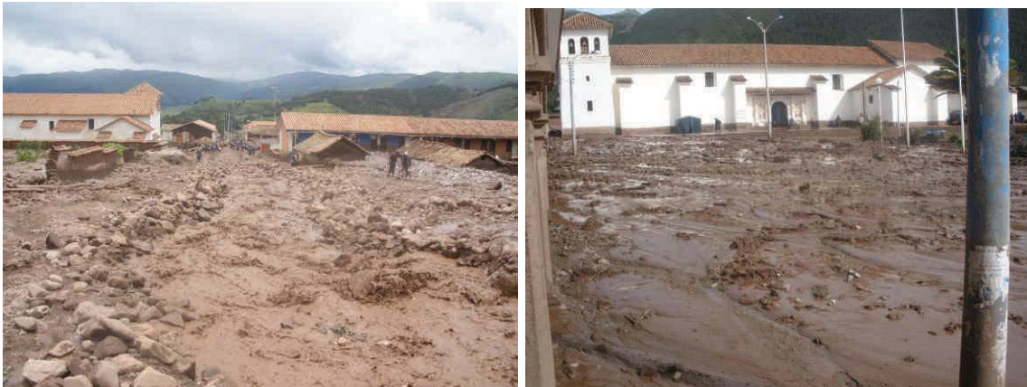
Figuras 10 y 11. Unidad Escolar Mixta Nro. 118 – Zurite y muchas viviendas afectadas por el aluvión ocurrido el día 6 de febrero del 2010 (izquierda). Plaza de Armas de Zurite tras el aluvión del 6 de febrero (derecha).
