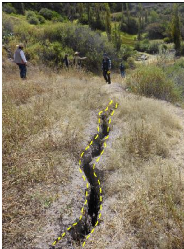
Figura 11. Agrietamientos G2 en terrenos de cultivo de Anascapa, (coordenadas UTM WGS84: 301957E, 8183219N)
