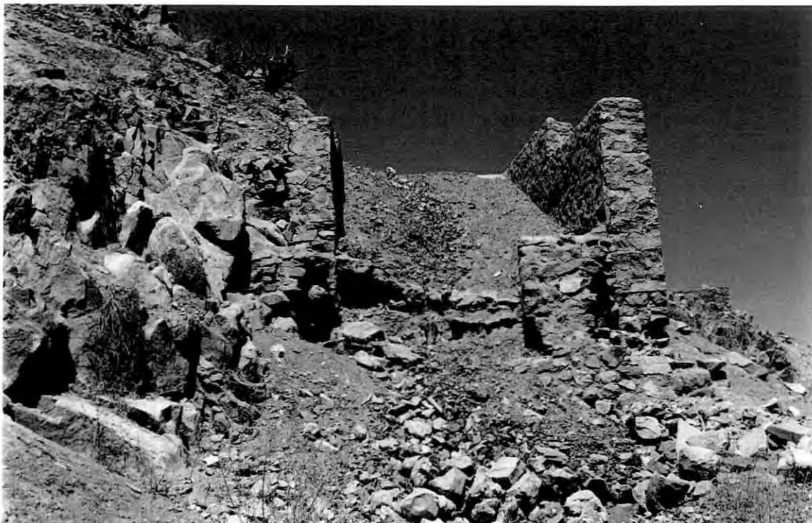
Mina Togenes, Tolva principal (en la parte inferior de la foto minerales oxidados de cobre)
