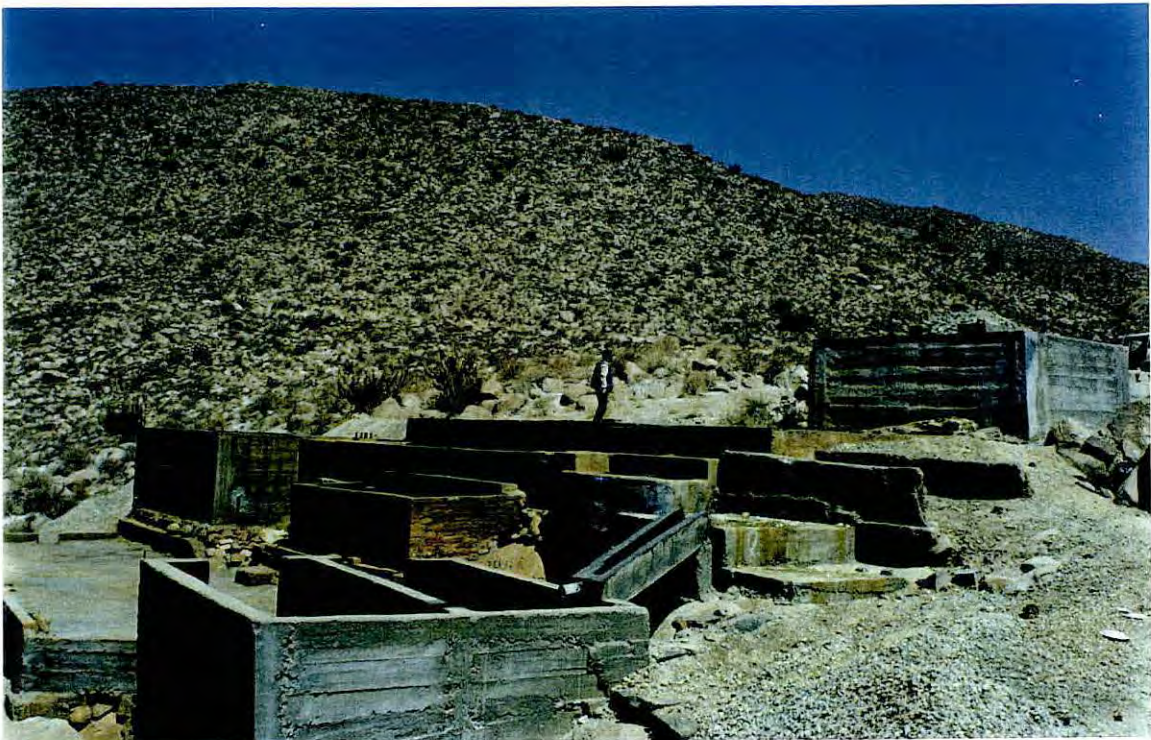
Pilas de lixiviación en el Cerro Espinal (Acido Sulfúrico para Oxidos de Cobre)
