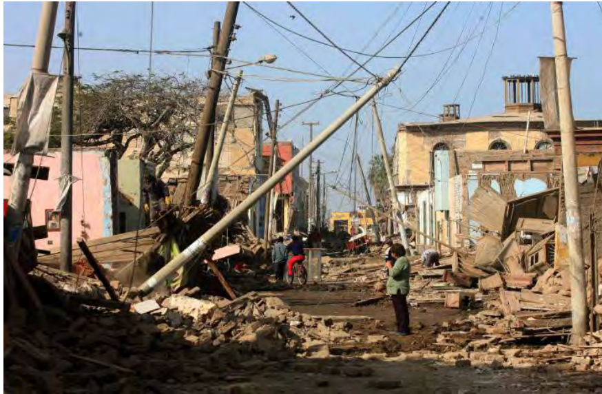
Foto IV-4. Terremoto ocurrido en Pisco en agosto de 2007, donde la población y las autoridades superaron su capacidad de respuesta; fue necesaria la intervención de ayuda a nivel nacional e internacional. (Foto: INDECI Pisco).
