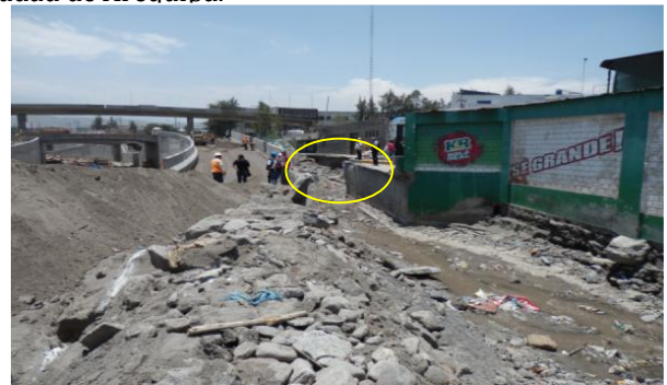
Figura 3. Vista del cauce estrechado de la torrentera Venezuela, cuando se produjeron las inundaciones en el 2013. El depósito de material alcanzó hasta 1 m de altura (Foto: Luque, 2013).
