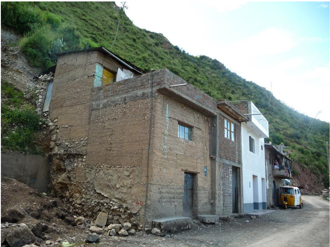
Foto N° 8. Ladera del cerro Huanchuco susceptible a derrumbes, la pendiente del terreno supera los 60°. Sector Prologación Sucre (Barrio Bellavista).
