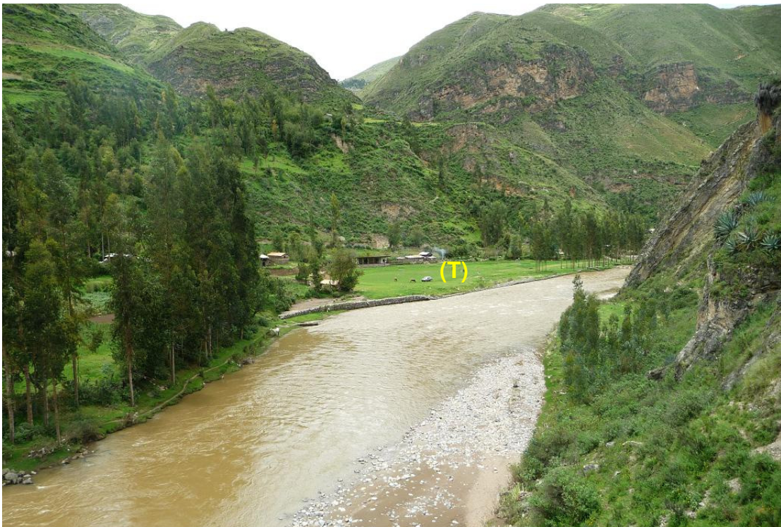
Foto N° 18. Terraza (T) susceptible a inundación y erosión fluvial. Sector Ocopa, margen izquierda del río Lircay.
