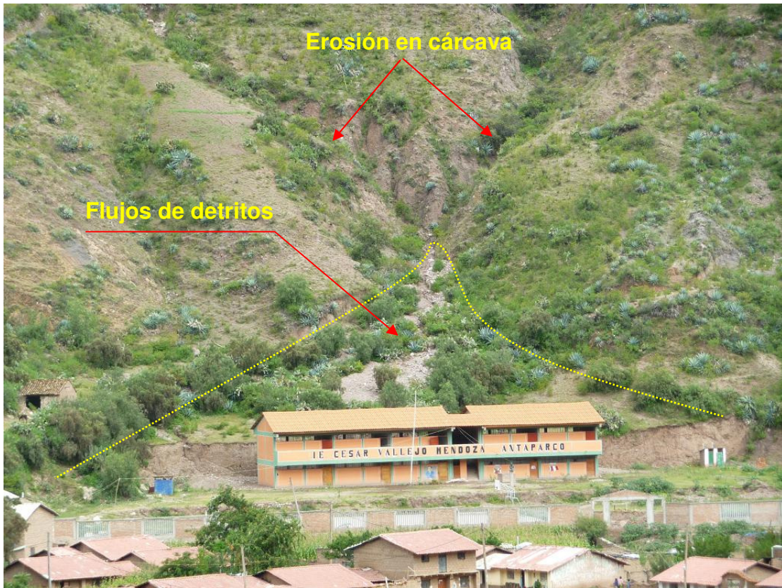
Foto N° 21: Vista panorámica de los peligros geológicos (flujo y erosión en cárcava) que pueden afectar a la Institución Educativa Cesar Vallejo Mendoza de Antaparco.
