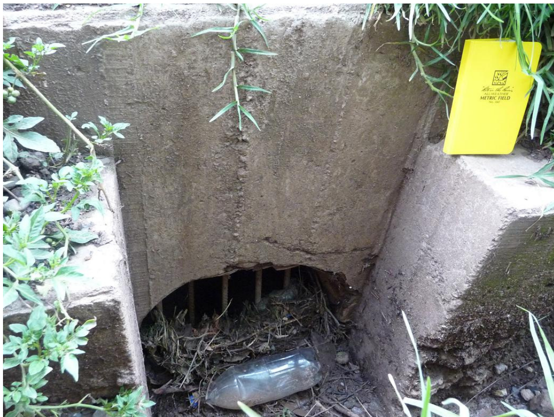
Foto N° 6. Comparación del tamaño del cuaderno (20cm) con el canal para drenar las aguas flujos de las cárcavas. Intersección del Jirón 6 de agosto y la vía de Evitamiento.
