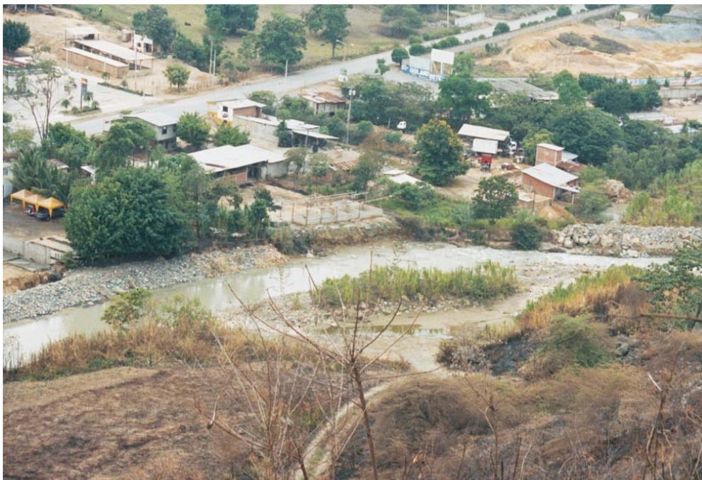
Foto N° 11.10 Puente Tumbes ubicado en el río del mismo nombre, de estructura metálica, se encuentra en buen estado. (S. Núñez, abril-2004).
