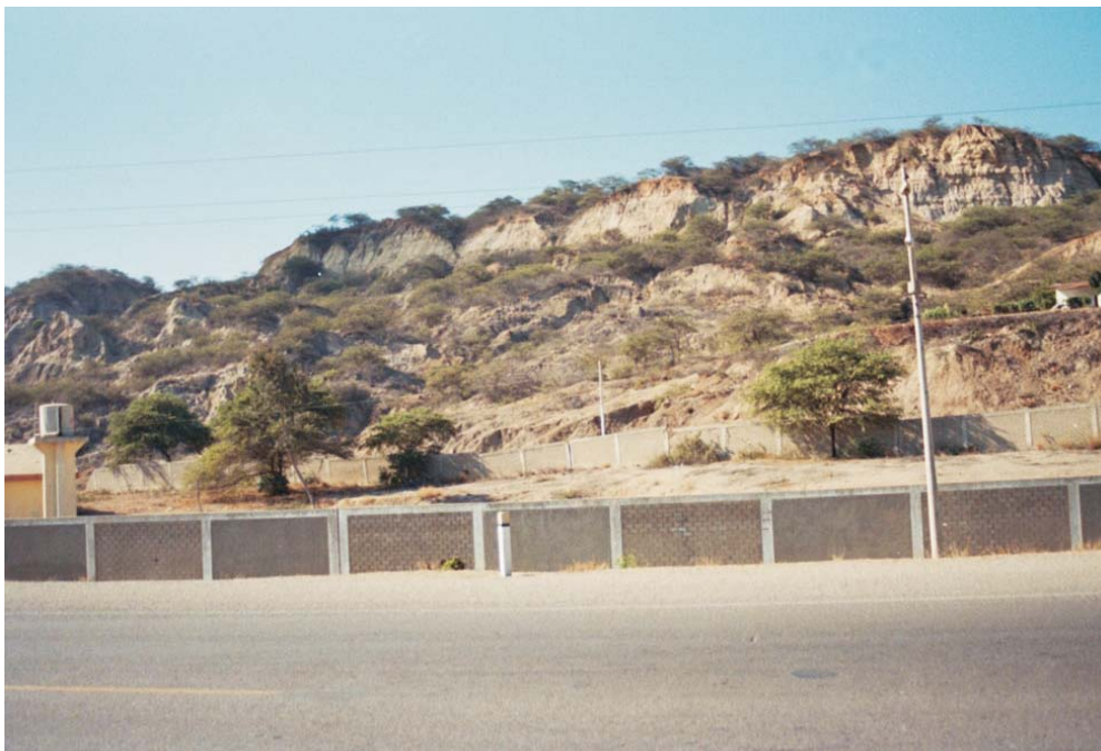
Fotos N° 7.1 Deslizamiento que afectó al centro educativo del A. H. Las Malvinas, puede afectar viviendas asentadas sobre el cuerpo del deslizamiento. Vista de SO a NE (S. Núñez, julio-2004).
