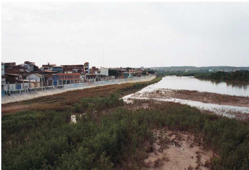
Fotos N° 11.15 Zonas inundables del río Tumbes, afecta terrenos de cultivo en la margen derecha, está protegida con muros de concreto, por la margen izquierda, la ciudad es susceptible a inundaciones. (S. Núñez, abril-2004).
