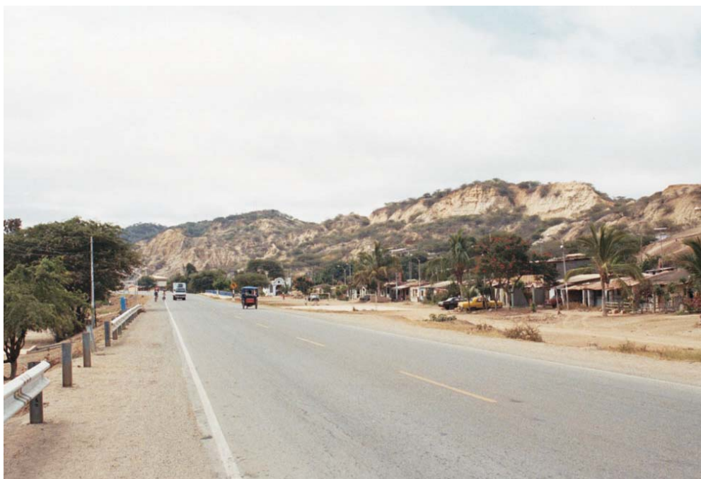
Fotos N° 11.1 Deslizamiento que está afectando al Centro Educativo del A. H. La Cruz. (S. Núñez, julio-2004)
