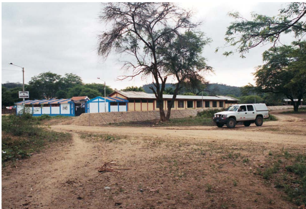
Foto N° 11.7 Zonas inundables del río Tumbes, en la margen derecha se han construido muros de contención, los cuales están protegiendo a la ciudad. (S. Núñez, abril-2004).
