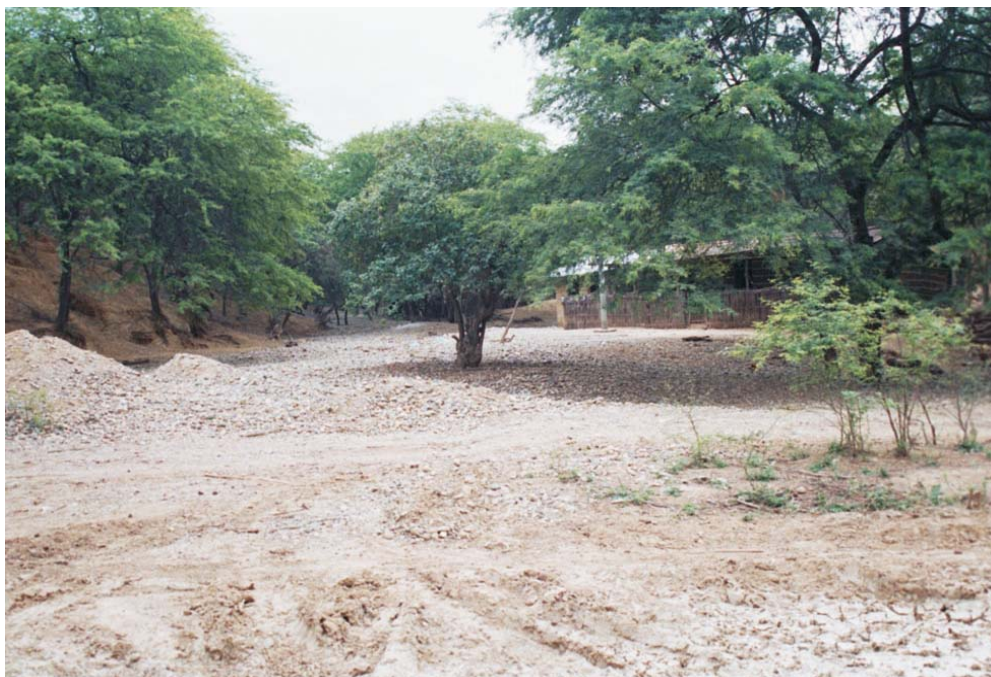
Foto N° 7.11 Huayco afectó viviendas del sector de Higerón, se observa vivienda y algarrobo como testigo de este evento (S. Núñez, abril-2004).
