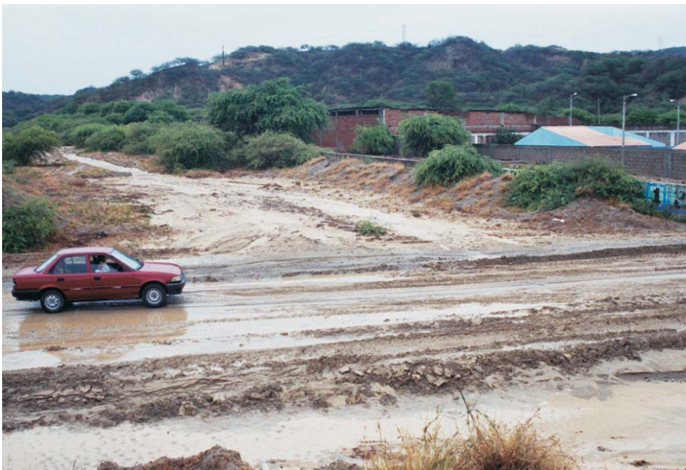
Foto N° 7.13 Flujo de lodo, ocurrido el 14/04/04, sobre la quebrada los Los Cedros, afectó la Carretera Panamericana Norte en el km 1257+900. (S. Núñez, julio 2004).
