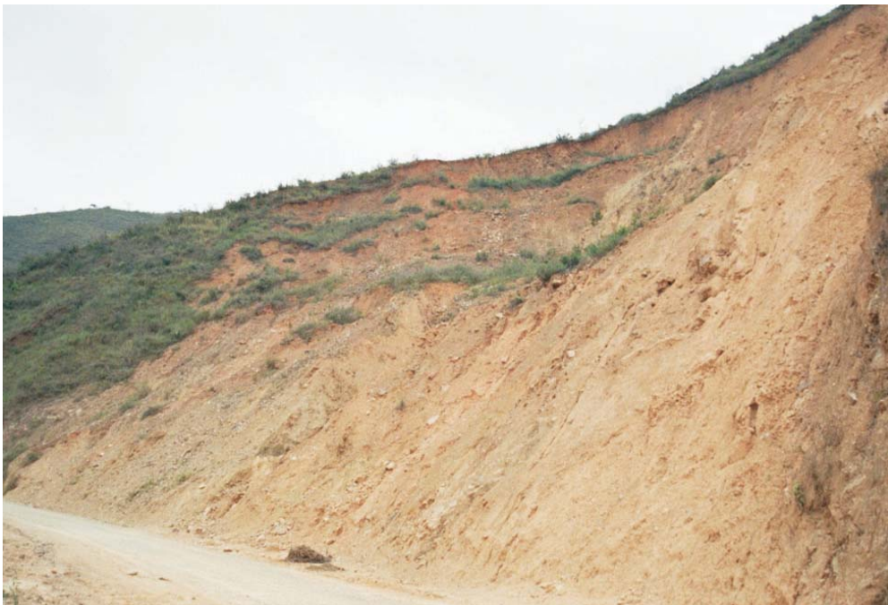
Foto N° 11.20 Deslizamiento que constantemente afecta tramo de 100 m de la carretera Guayquichuma-Jorupe-Loja, puede represar la quebrada Jorupe (?). Similares ejemplos se presentan en este tramo de la carretera. (S. Núñez, noviembre-2004).
