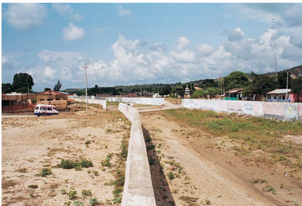
Foto N° 11.2 Flujo de lodo que pasa por la quebrada San Juan, se presenta generalmente con el fenómeno El Niño o con lluvias de tipo excepcional. Esta quebrada se encuentra canalizada. (S. Núñez, mayo-2004).
