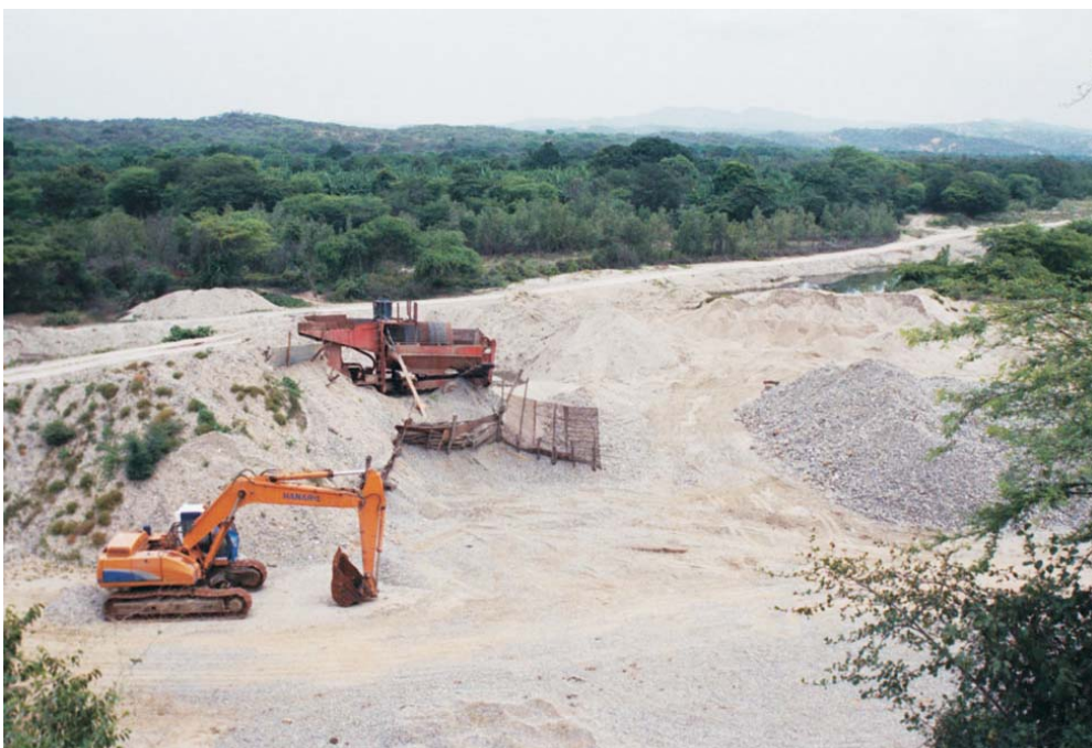
Foto N° 10.1 Zona de canteras en la quebrada Angostura, ubicadas a la altura de Cabuyal. (S. Núñez, mayo-2004).
