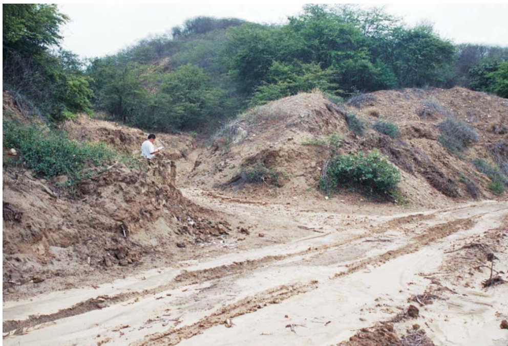
Foto N°11.17 Flujos de lodo en el sector de La Jota, ocurrido el 14/04/04, afectó a la carretera afirmada La Jota-Canteras. (S. Núñez, abril-2004).
