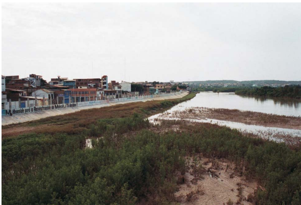
Fotos N° 11.8 Zonas de erosión e inundación fluvial, por la dinámica del río Amarillo, sector de Portovelo Ecuador. (S. Núñez, diciembre-2004).
