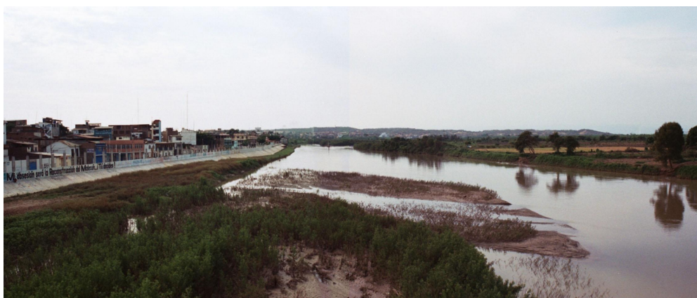
Foto N° 5.9 Zonas inundables del río Tumbes (margen Izquierda), al frente de la ciudad de Tumbes, vista tomada desde el puente Tumbes, aguas abajo (S. Núñez, abril-2004).
