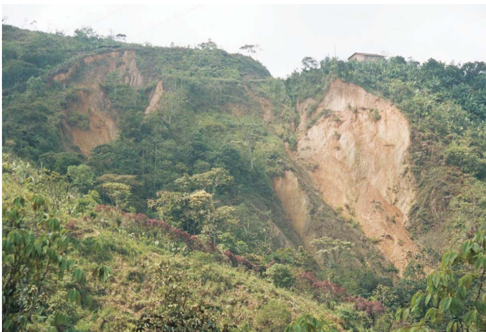
Foto N° 7.2 Deslizamientos en la carretera Balsas-Pindo, sector de San José, se observa también erosión en cárcavas (S. Núñez, noviembre-2004).
