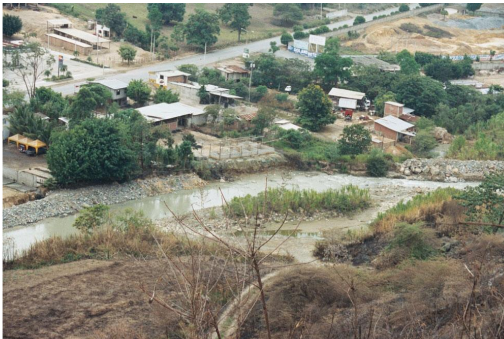
Foto N° 11.9 Zona de erosión fluvial e inundación fluvial, donde el río afecta viviendas del centro poblado Galeras y riberas que se localizan en la terraza inferior, las defensas ribereñas no cumplen su misión. (Núñez S., noviembre-2004).
