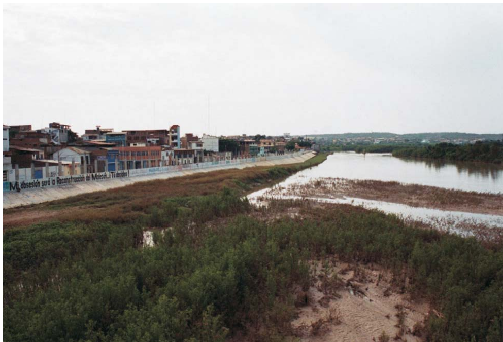
Foto N° 7.19 Zonas inundables del río Tumbes. La ciudad protegida con muros de concreto (S. Núñez, abril-2004).
