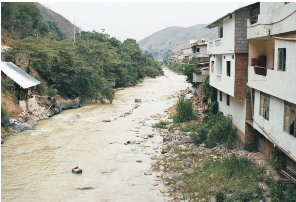
Foto N° 7.22 Erosión de ribera en ambas márgenes del río Amarillo, el sector de Portovelo, las viviendas se han construidas en pleno cauce del río, en tiempos de crecida, es posible que sean afectadas. (S. Núñez, noviembre-2004).
