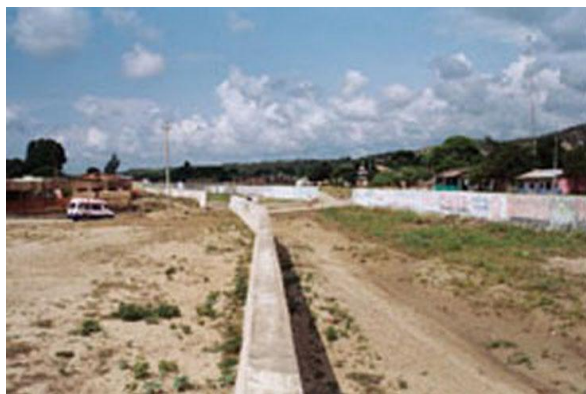
Foto N° 5.7 Quebrada San Juan (S. Núñez, noviembre-2004).
