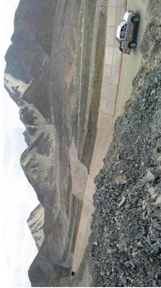
Fotografía 9.23 Depósitos de flujo de déritos, sector Túnel 08 del proyecto Chavimochic, distrito Chao, provincia de Virú.
