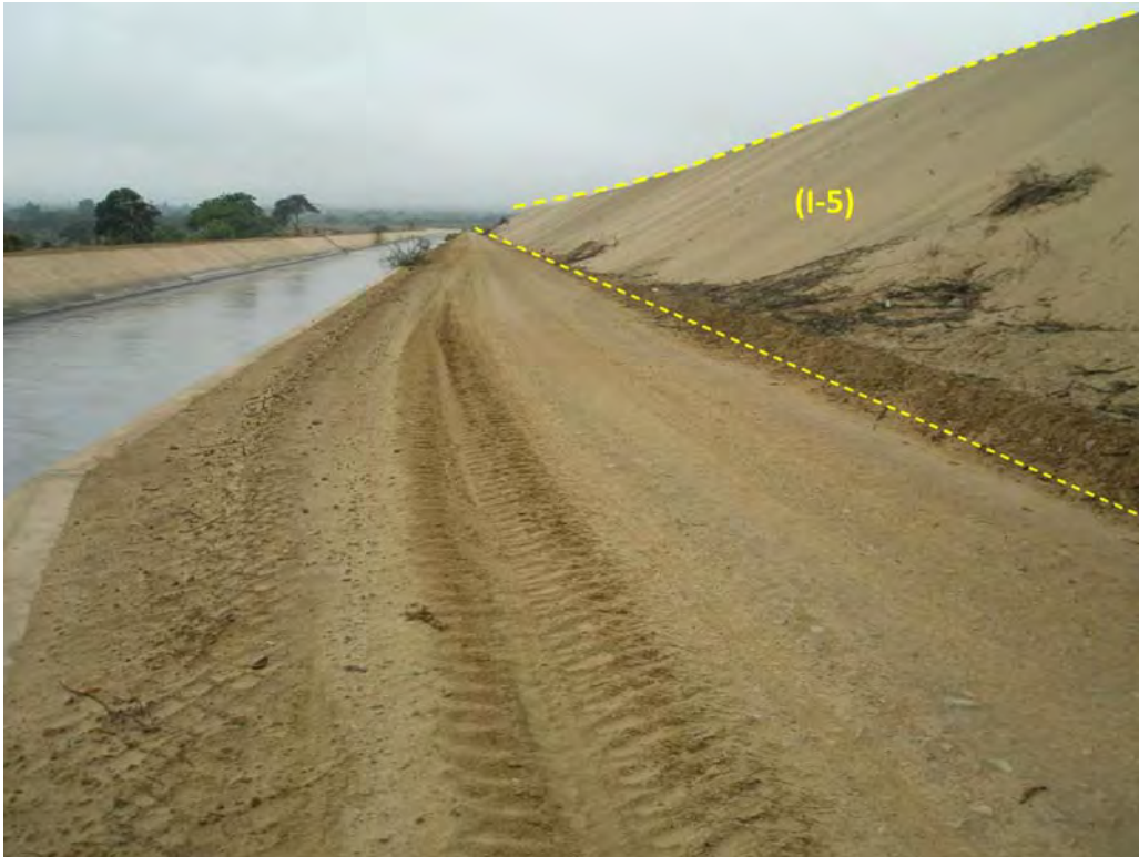
Fotografía 3.3 Depósitos eólicos (I-5) ubicados en la margen derecha del canal de riego del Proyecto Chavimochic.
