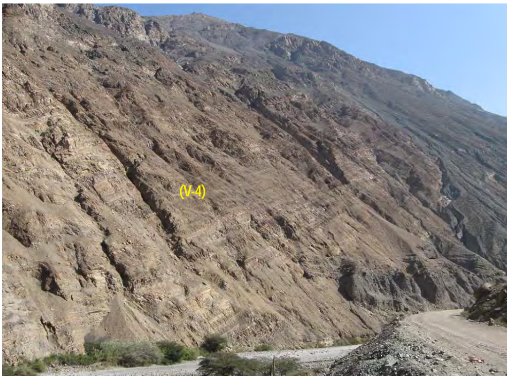
Fotografía 3.8 Intercalación de lutitas, lodolitas y areniscas de la subunidad V-4 afectada por la erosión de ladera. Margen derecha del río Tablachaca, cerca al desvío Cabana.
