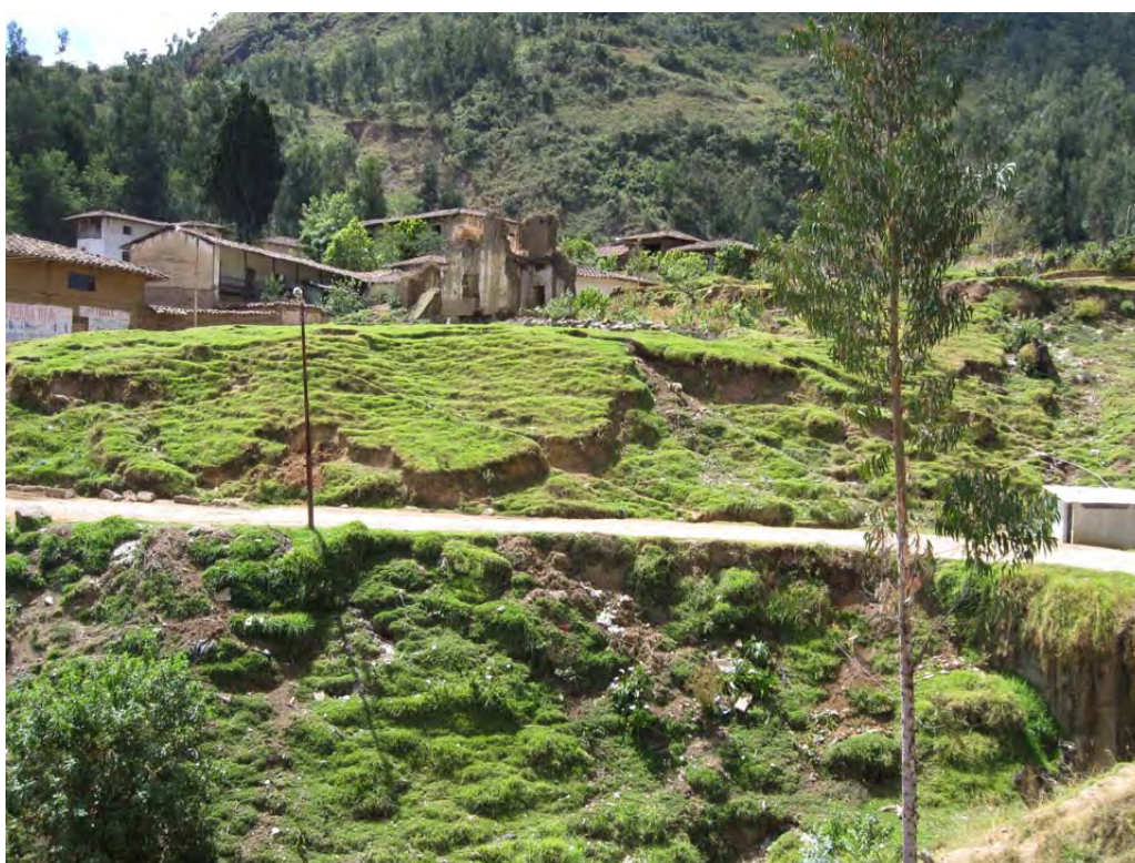
Fotografía 7.10 Reptación de suelos. Talud superior del pueblo de Cachicadán, provincia de Santiago de Chuco.
