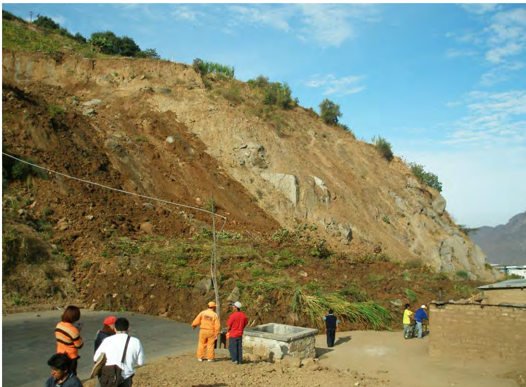
Fotografía 7.2 Derrumbe en talud superior de carretera. Tramo Trujillo-Otuzco, sector Plazapampa, provincia de Otuzco.
