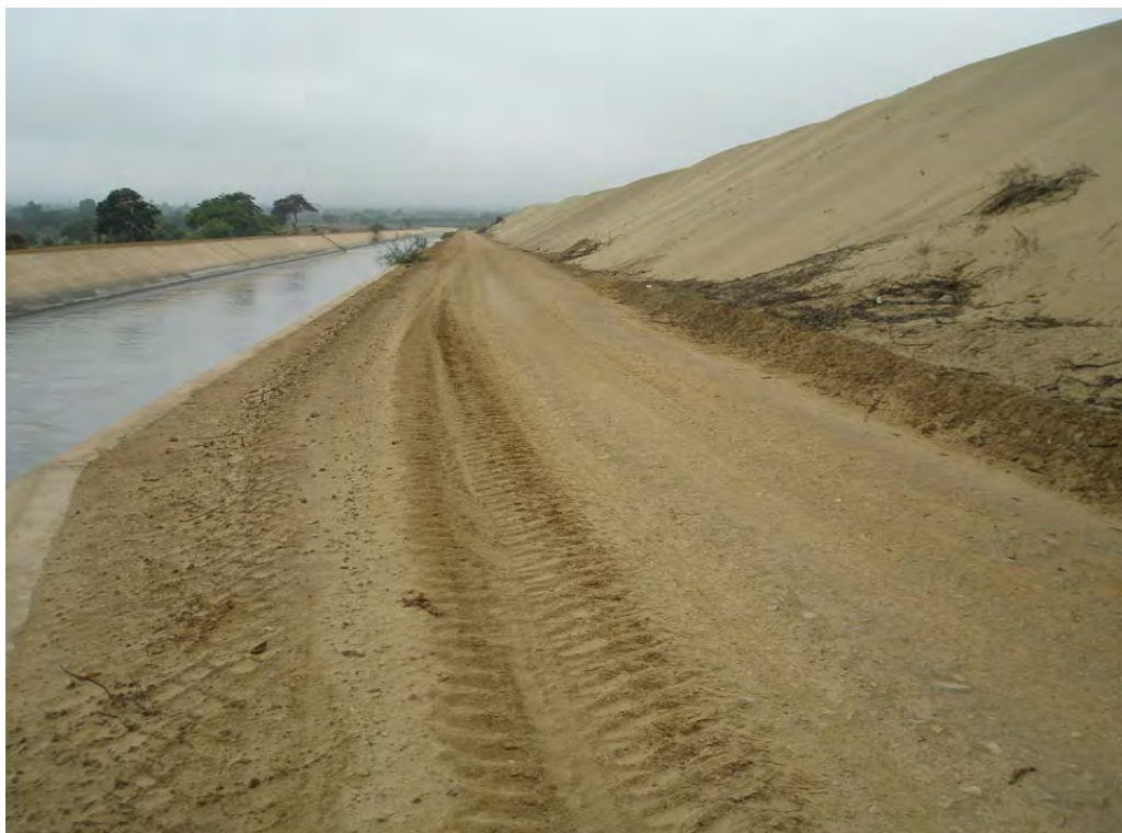
Fotografía 7.17 Mantos de arena en la margen derecha del canal de riego del Proyecto especial Chavimochic ubicado en el sector del Cerro Urango, distrito Chao, provincia Virú.
