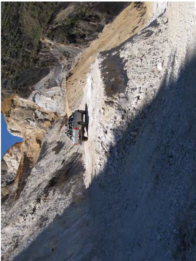
Fotografía 9.34 Área susceptible a derrumbe-flujo en la parte alta de Adaumas, distrito de Sanagoran, provincia Sánchez Carrión.
