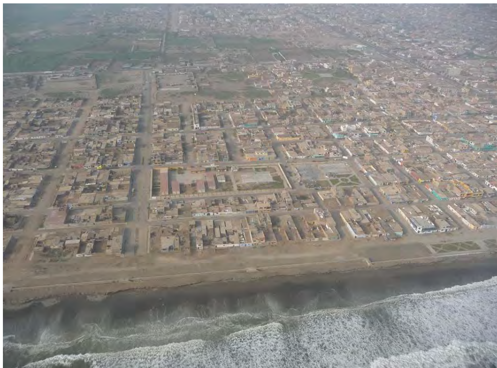
Fotografía 7.26 Erosión marina al oeste de la ciudad Víctor Larco Herrera, provincia Trujillo.
