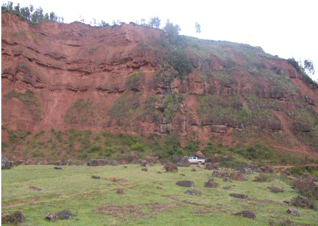
Fotografía 7.1 Caída de rocas. Cerro Atacolpa, distrito Tayabamba, provincia Pataz.
