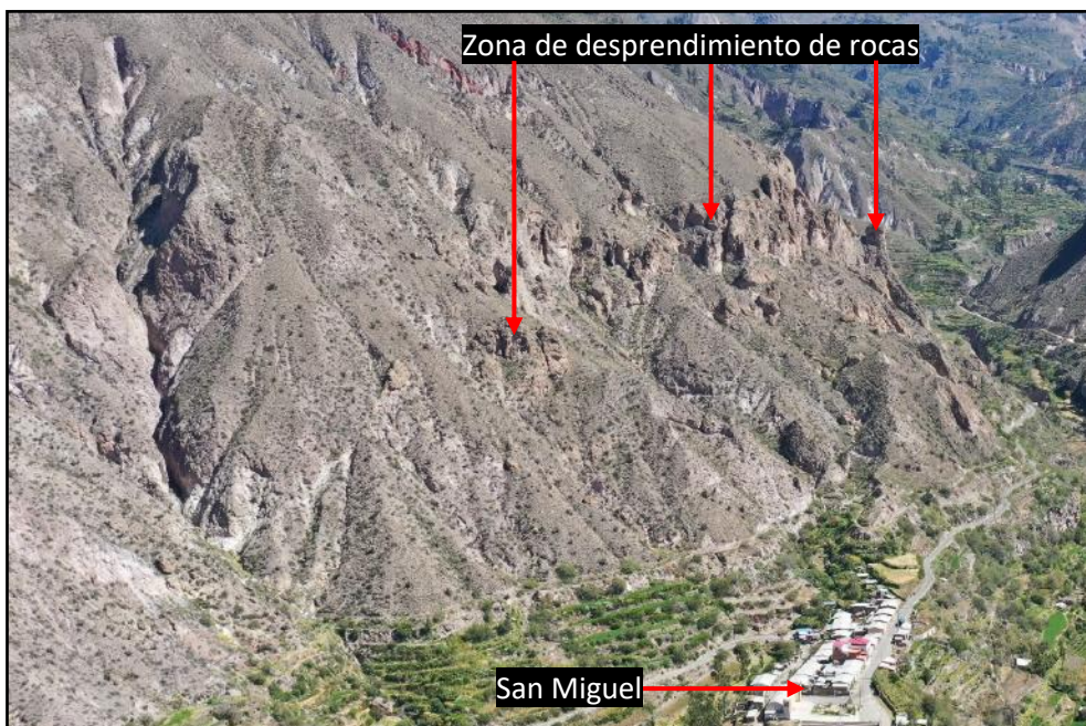
Figura 11. Zona de desprendimiento de rocas, desde la parte alta de San Miguel.
