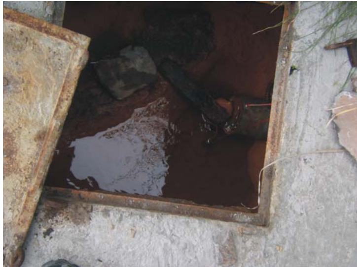
Fig. 51 Fuente Ubinas Termal.
