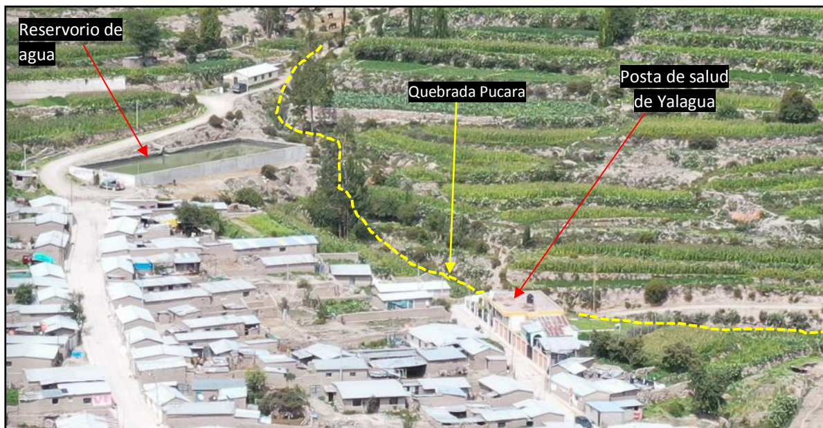
Figura 16. Infraestructura próxima al cauce de la quebrada Pucará
