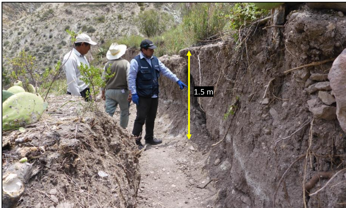
Figura 7. Salto de escarpe deslizamiento Da1 en Yalagua, (coordenadas UTM WGS84: 312857E, 8198788N)
