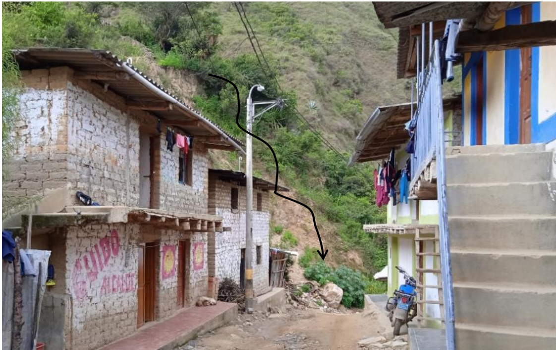
Figura 27. Caídas de rocas en las coordenadas 9447870N y 647410E.
