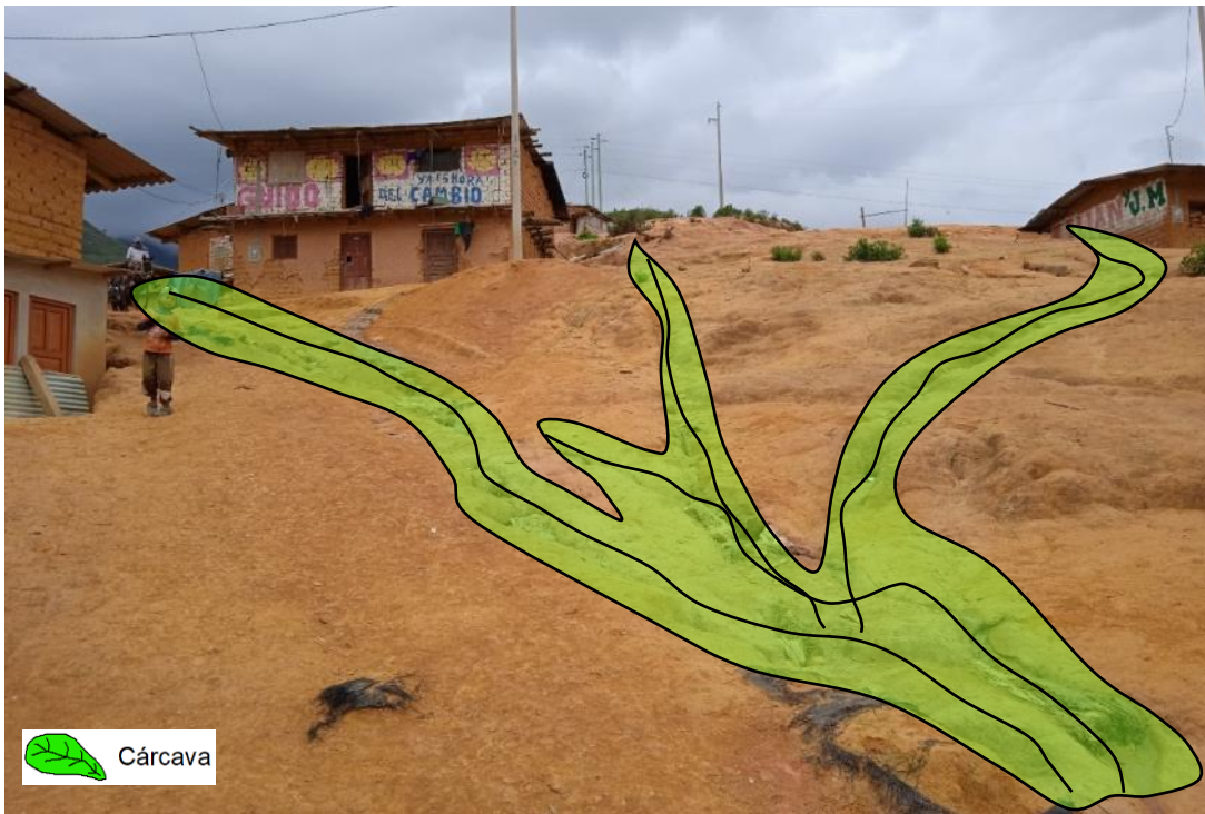
Figura 21. Vista de calles en el AA.HH. Sagrado Corazón en las coordenadas 9447408N y 647800E
