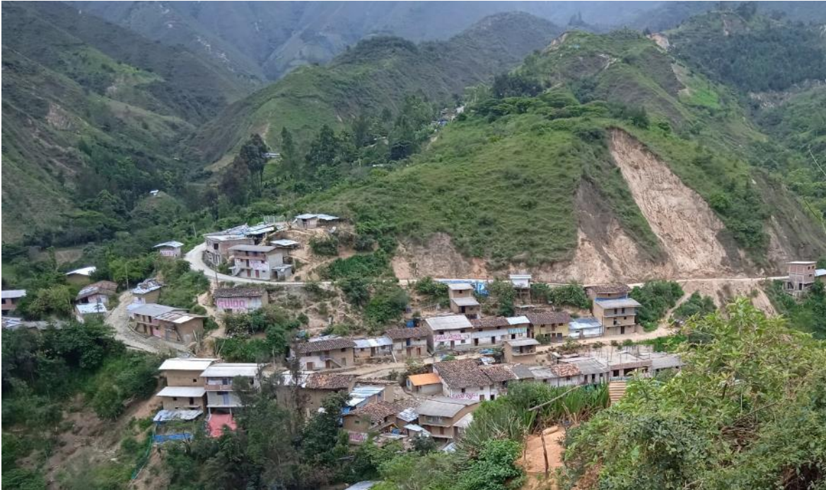
Figura 42. Deslizamientos en la vía Pacaipampa - Ayabaca.
