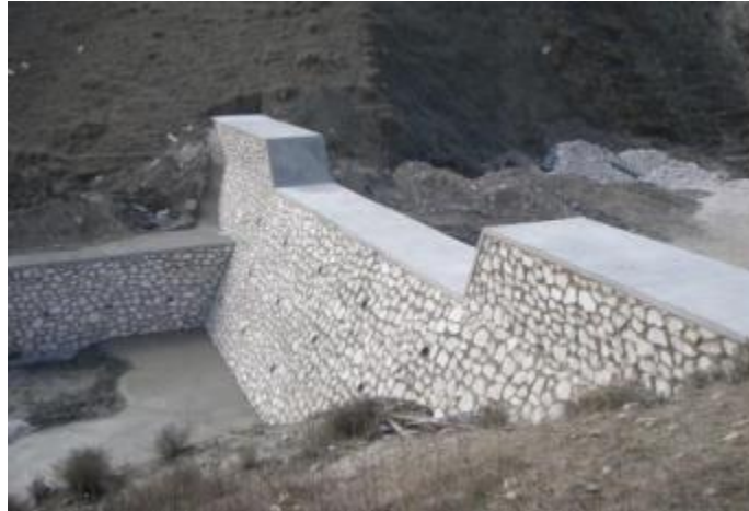
Figura 51. Dique de mampostería.
