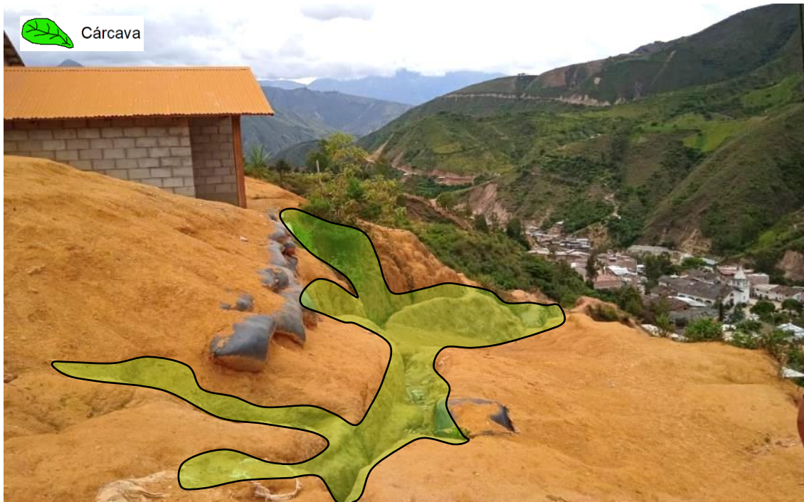
Figura 23. Laderas próximas al área urbana de Pacaipampa afectadas por cárcavas, coordenadas 9493135N y 633906E.
