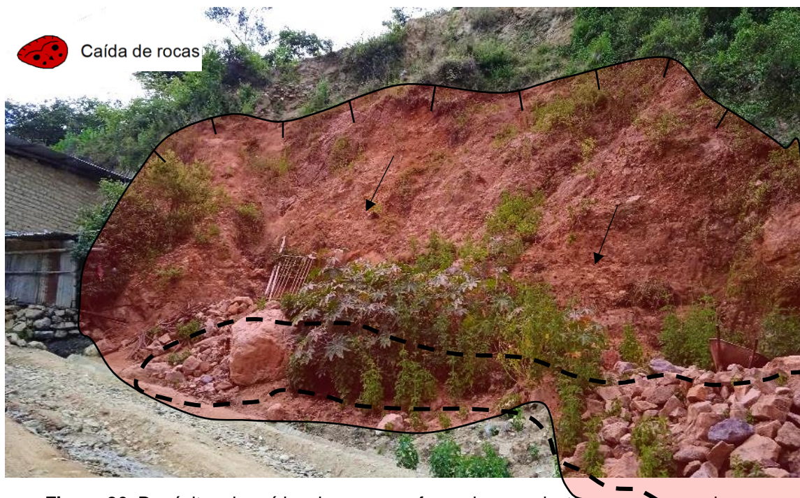
Figura 26. Depósitos de caídas de rocas conformadas por clastos y gravas angulosas, coordenadas 9447870N y 647410E.
