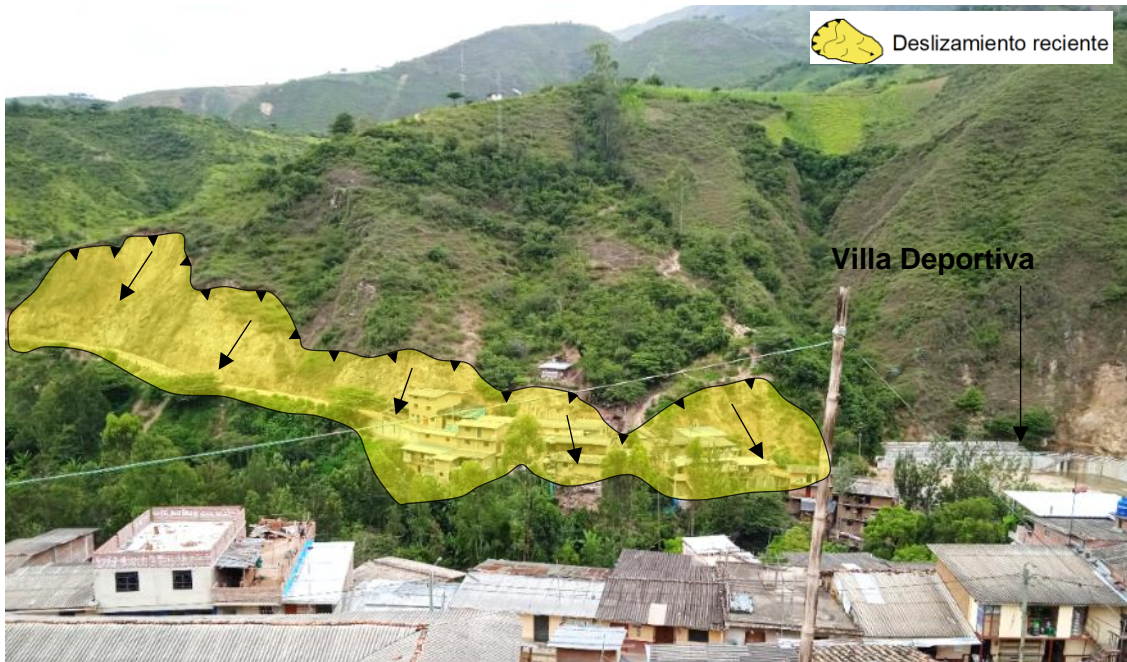
Figura 24. Vista de sur a norte del sector Villa Deportiva ubicada en las coordenadas: 9447879N y 647295E.
