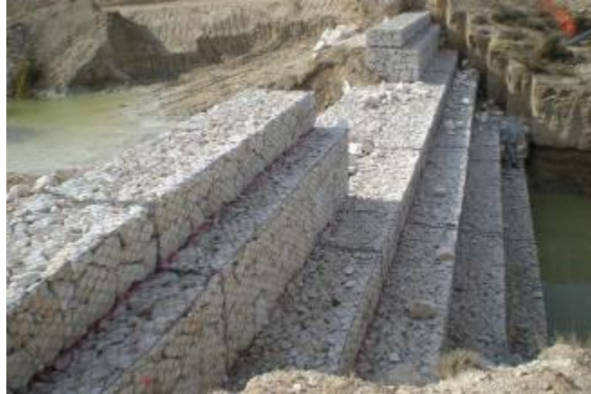
Figura 52. Dique de gaviones.
