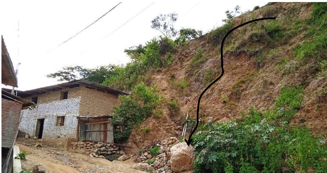
Figura 39. Viviendas afectadas por caídas de rocas.
