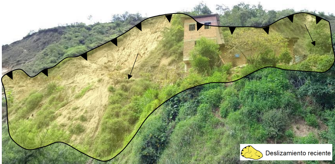
Figura 28. Zona de deslizamiento en el sector Ramón Castilla.
