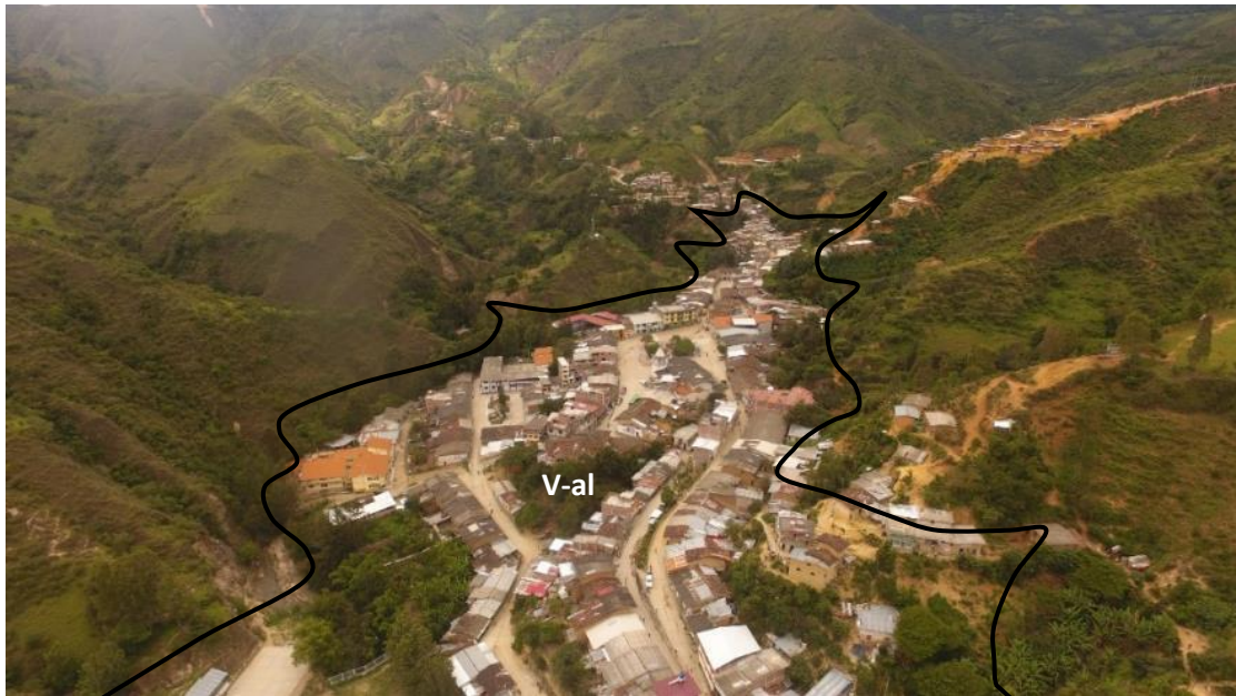
Figura 08. Vista panorámica del piedemonte donde se ubica gran parte del área urbana de Pacaipampa.
