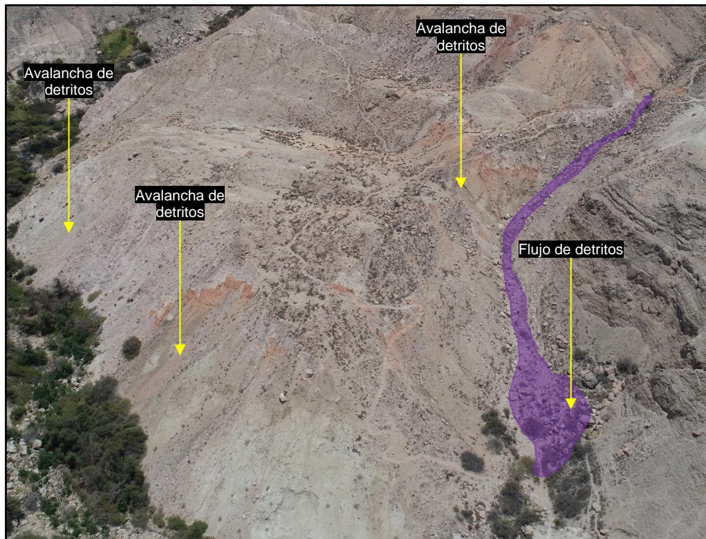
Figura 7. Avalancha de detritos en el sector Llacas
