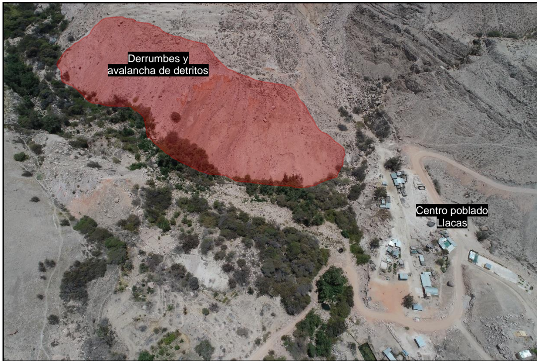
Figura 6. Derrumbes en el sector Llacas
