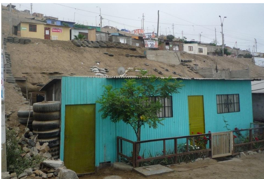
Foto 9. Sector de Héroes del Cénepa, se muestra la pendiente del terreno y su inestabilidad.
