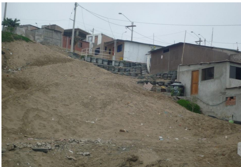
Foto 2. Viviendas precarias en el sector evaluado.
