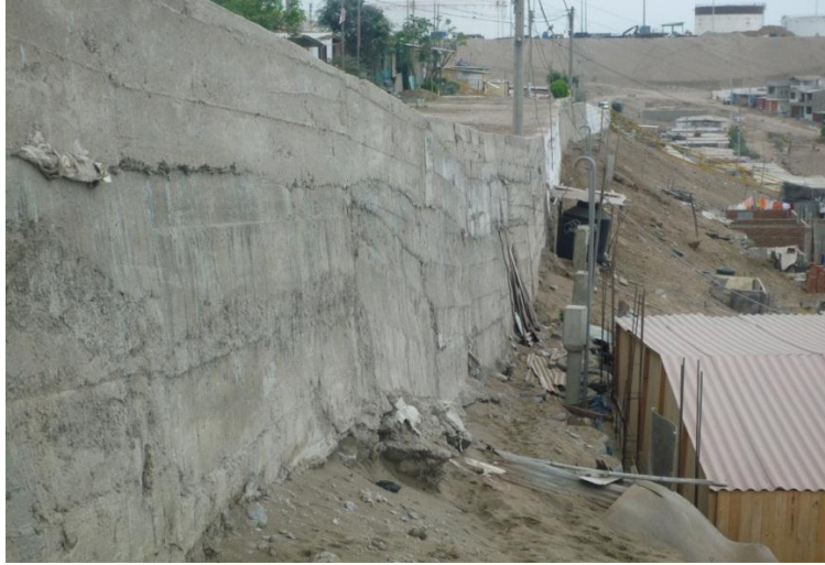
Foto 17. Sector Héroes del Cénepa, se observa el muro de contención, que su base está quedando inestable,
