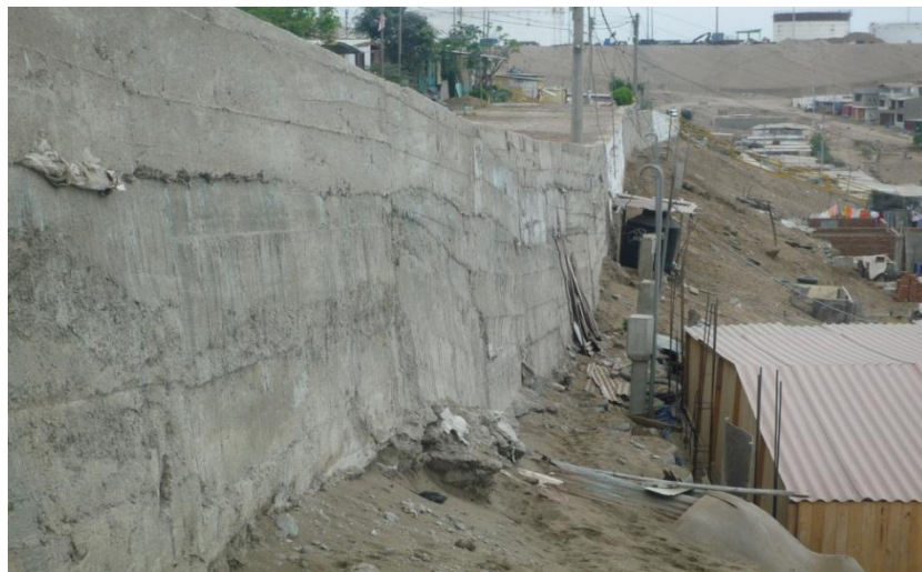
Foto 5. Muro de protección, A.H. Héroes del Cénepa.
