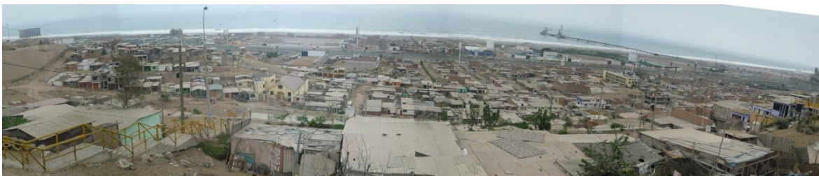
Foto 1. Vista panorámica de los AA.HH. ubicados en una ladera de Lomo de Corvina.
