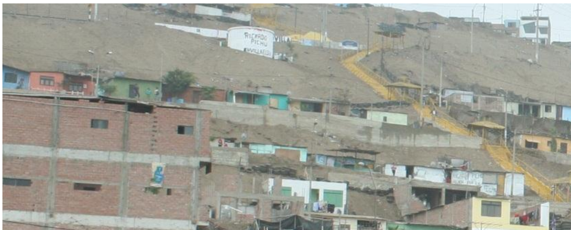
Foto 12. Obsérvese las obras realizadas en las laderas susceptibles a derrumbes: se aprecia un tanque de agua potable, escaleras y muros de contención.
