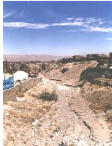
Torrentera San Lázaro, disminución del cause, aumento del riesgo.
