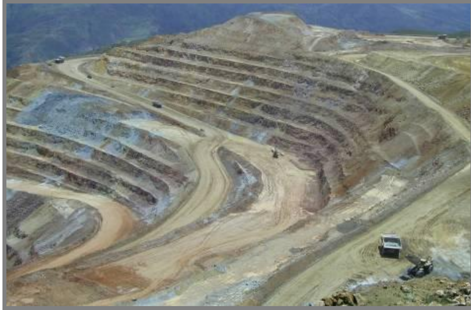
Foto N° 22.- Vista del depósito de Pierina.
