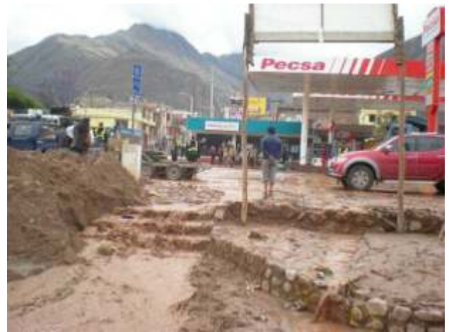
Foto 7. Avenida Circunvalación inundado por flujo de lodo
