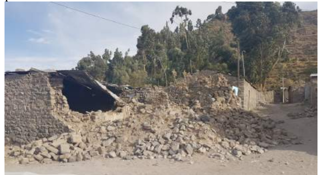
Foto 9. Vivienda colapsada por efecto de la amplificación de ondas sísmicas, el suelo y el tipo de construcción.
